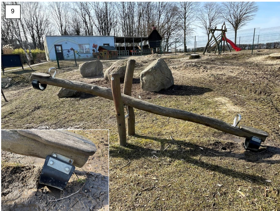
Wippe mit Puffer 4m lang, Ø 15cm, 4 Fundamente, 1x Schraube ergänzen, schleifen und streichen → versetzen
