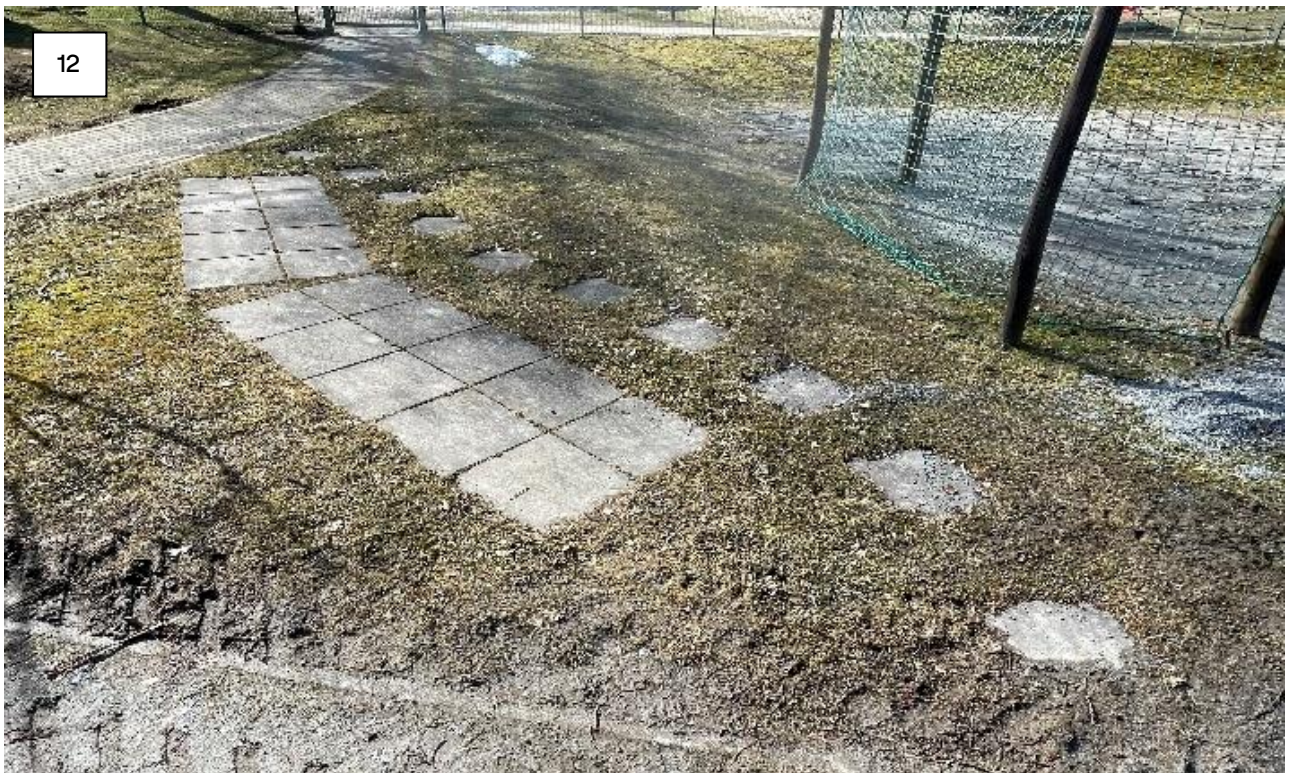
30 Stk. Betonplatten 50cm x 50cm → versetzen?
