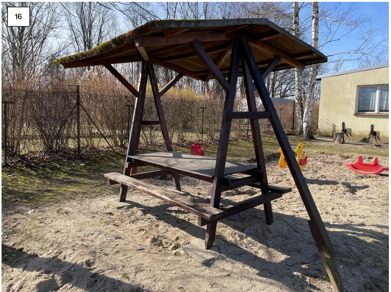
überdachte Sitzgarnitur 2m x 3m, h=2,30m (Abbruch)
