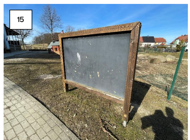
Tafel 2m x 1,80m, 2 Fundamente ( Abbruch )
