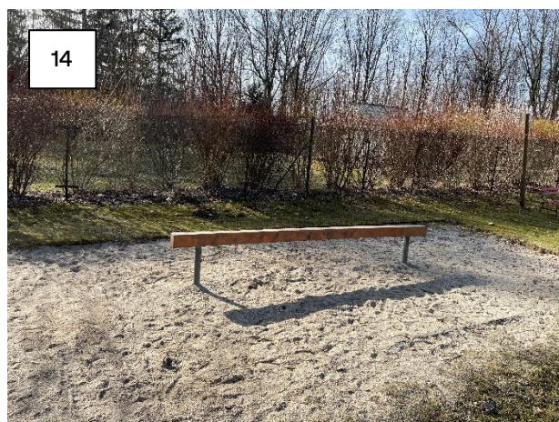
Balancierbalken 4m lang, h=50cm, 2 Fundamente, Fallschutz -> Erhalt für öffentl. Spielplatz
