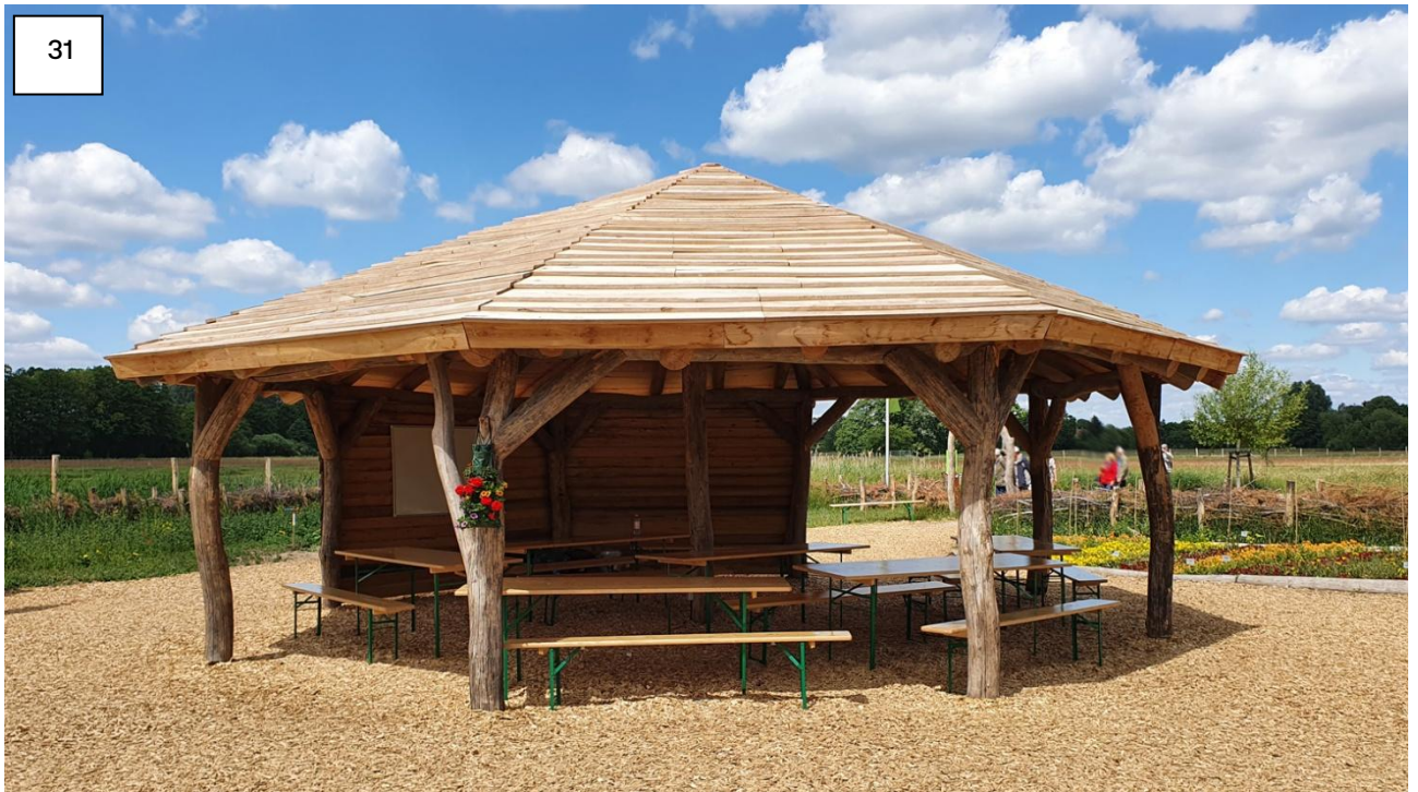
Pavillon aus Robinie, rund Ø ca. 6m mit Überdachung
