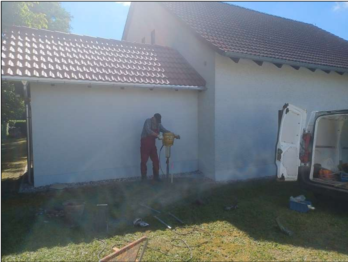
Abbildung 2: Bohrpunkt RKS 1 neben dem vorhandenen Anbau
