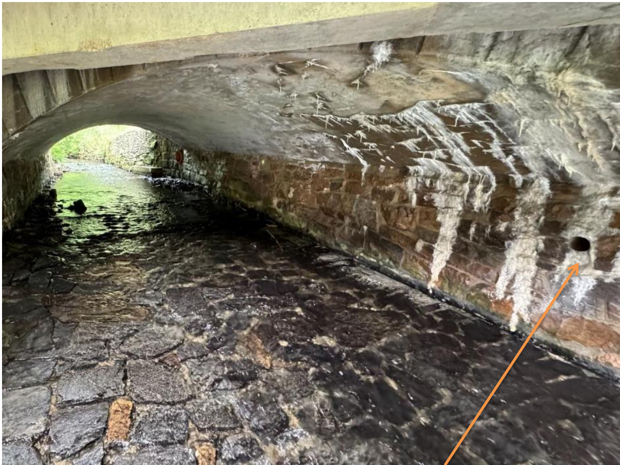
Lage Diamantkernbohrung (DKB) Nr. V
