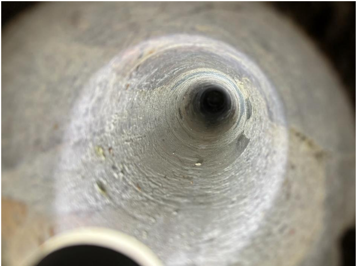
Detail Innenansicht Bohrloch der Diamantkernbohrung (DKB) Nr. IV
