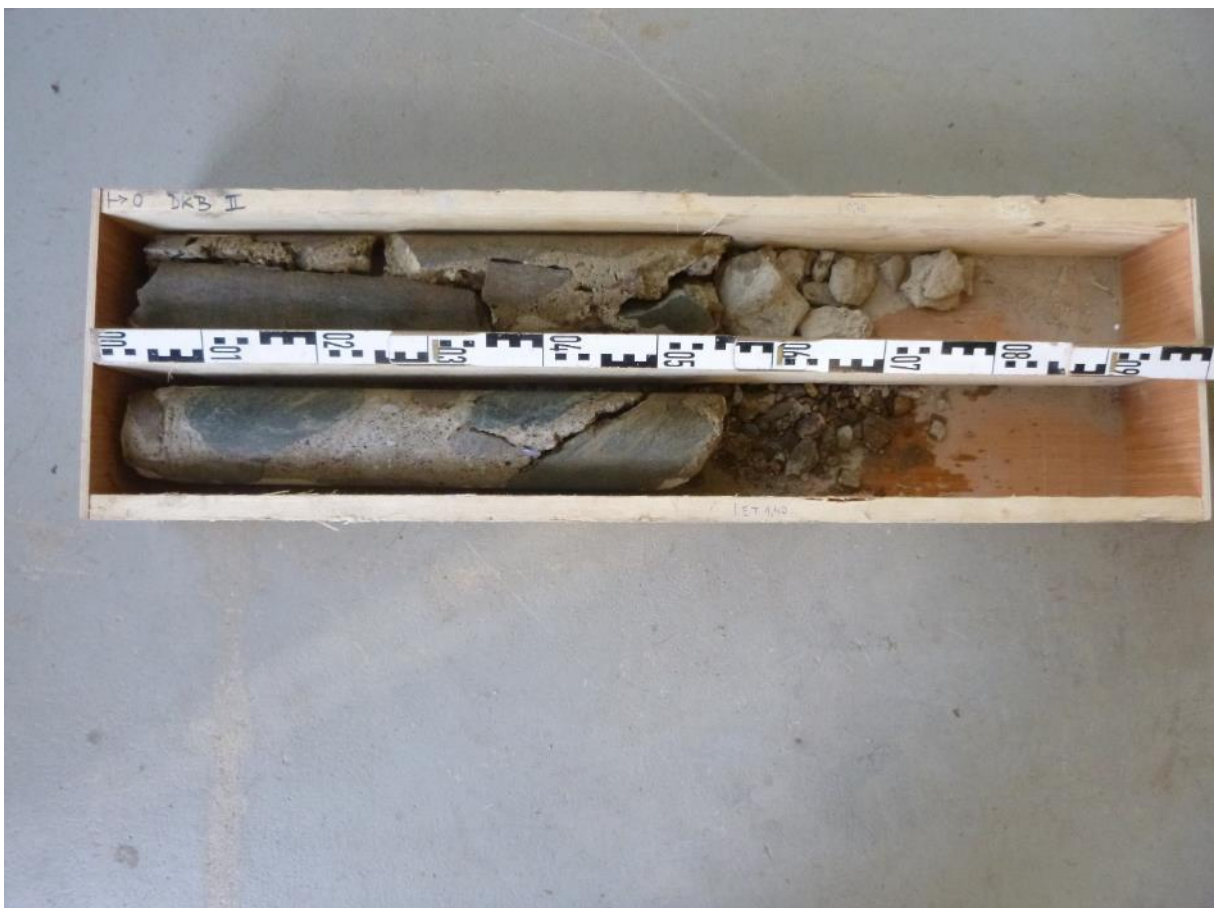
Detail Ansicht Betonbohrkern der Diamantkernbohrung (DKB) Nr. II
