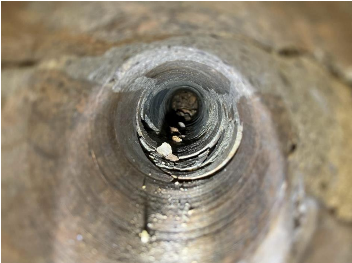
Detail Innenansicht Bohrloch der Diamantkernbohrung (DKB) Nr. V
