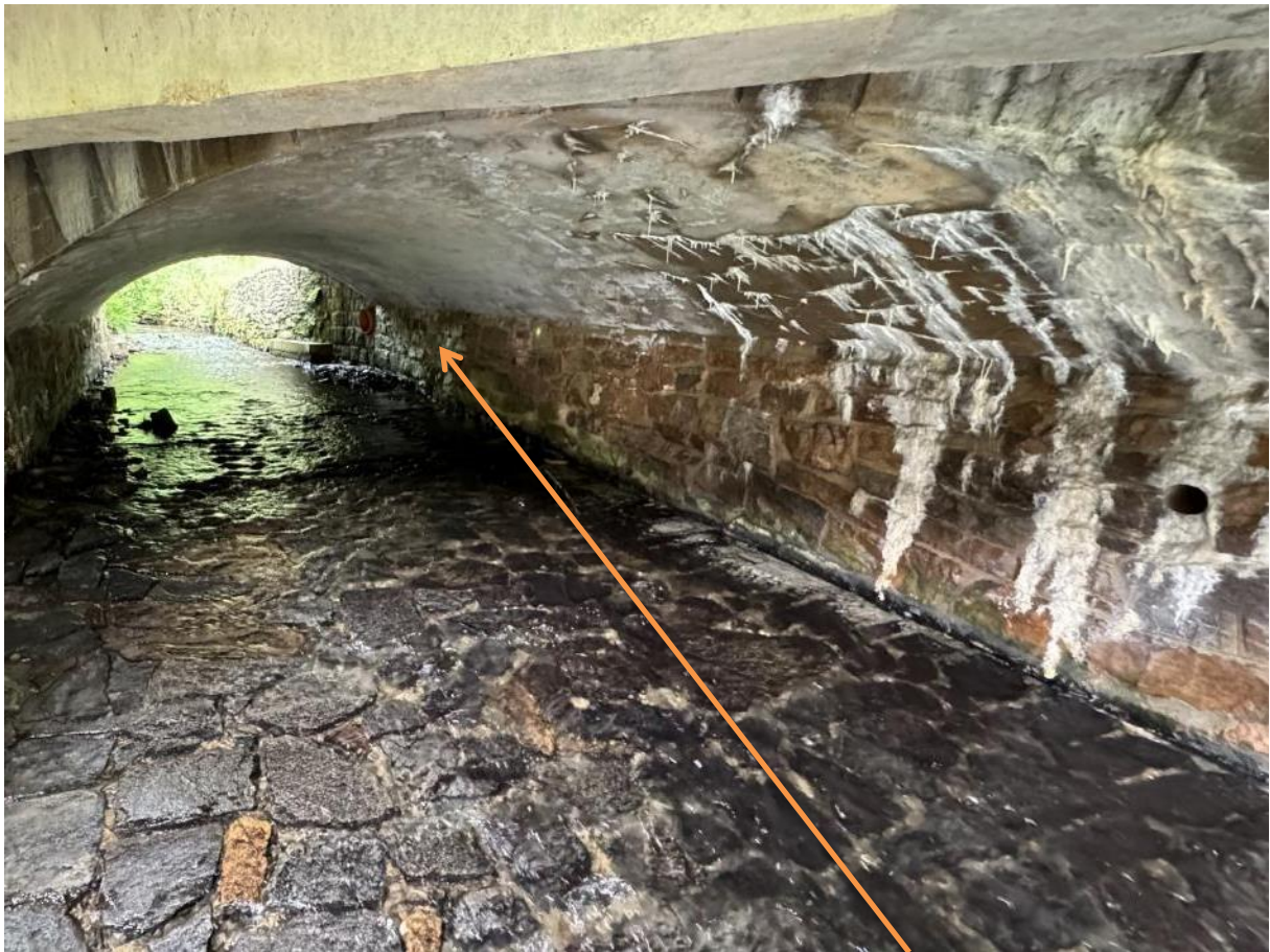
Lage Diamantkernbohrung (DKB) Nr. I
