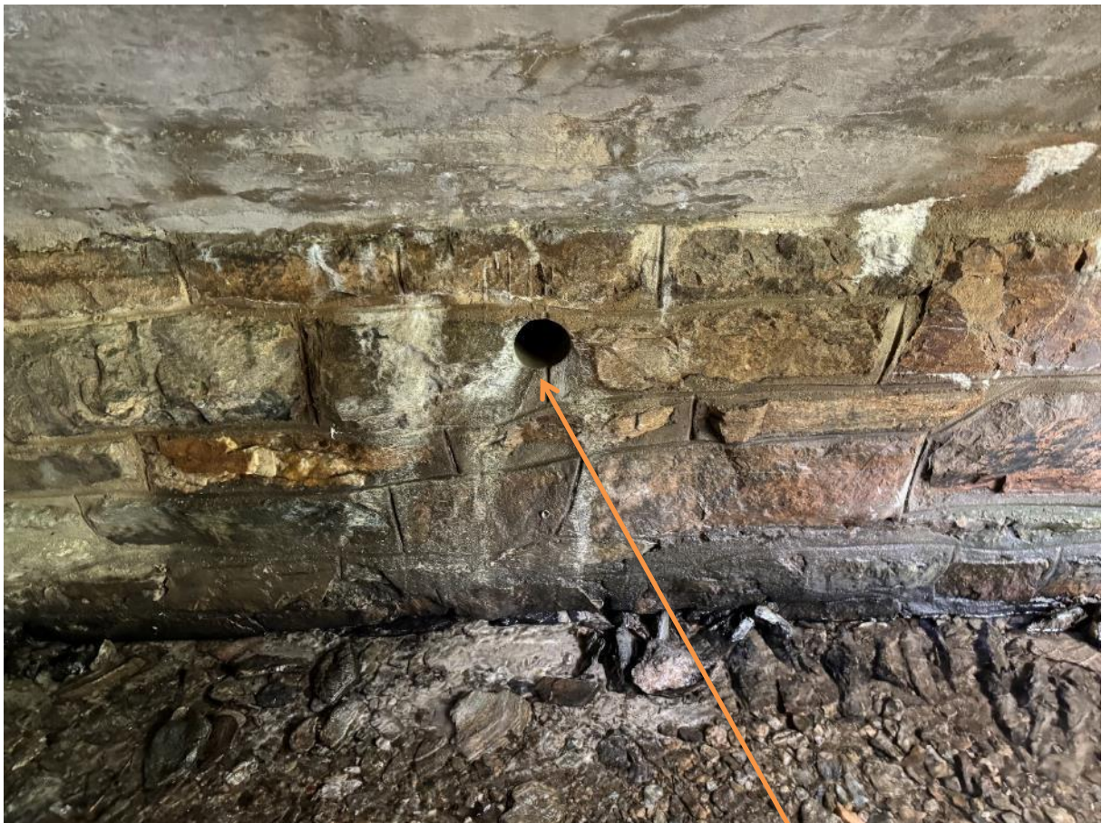
Lage Diamantkernbohrung (DKB) Nr. II
