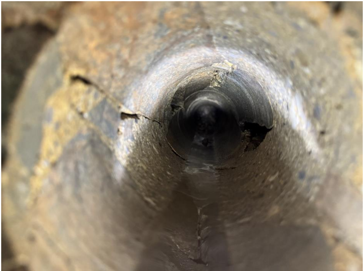
Detail Innenansicht Bohrloch der Diamantkernbohrung (DKB) Nr. I
