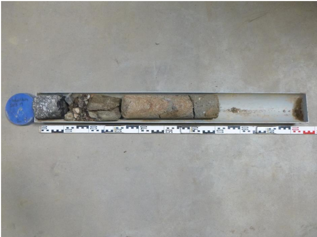
Detail Ansicht Betonbohrkern der Diamantkernbohrung (DKB) Nr. VI
