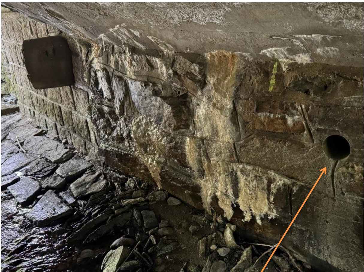
Lage Diamantkernbohrung (DKB) Nr. IV
