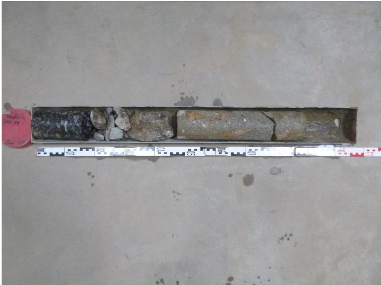
Detail Ansicht Betonbohrkern der Diamantkernbohrung (DKB) Nr. VII
