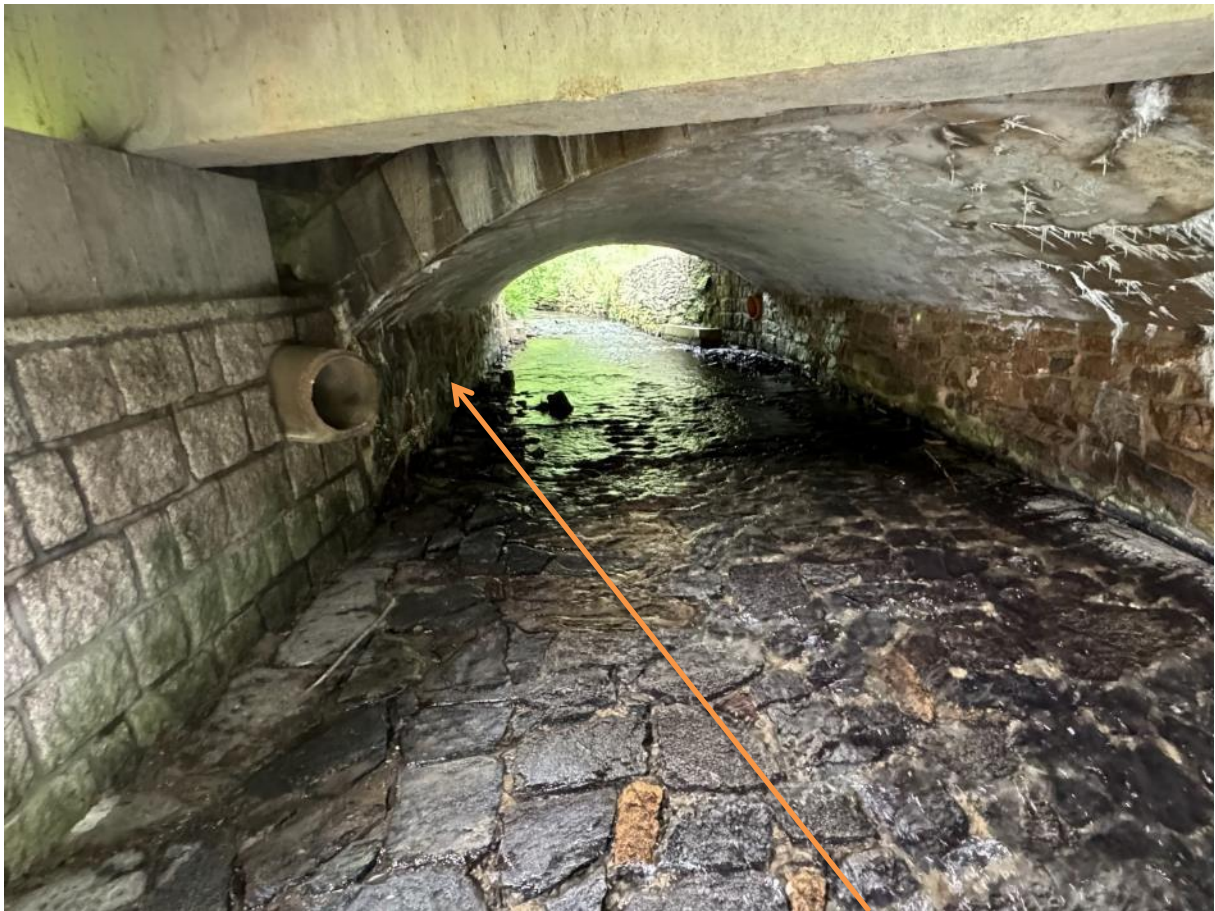
Lage Diamantkernbohrung (DKB) Nr. IV
