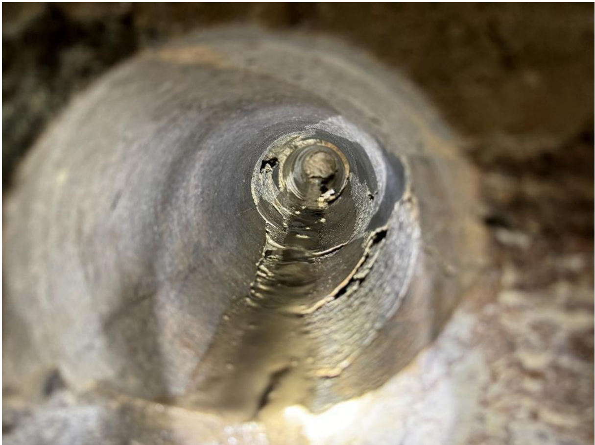
Detail Innenansicht Bohrloch der Diamantkernbohrung (DKB) Nr. II
