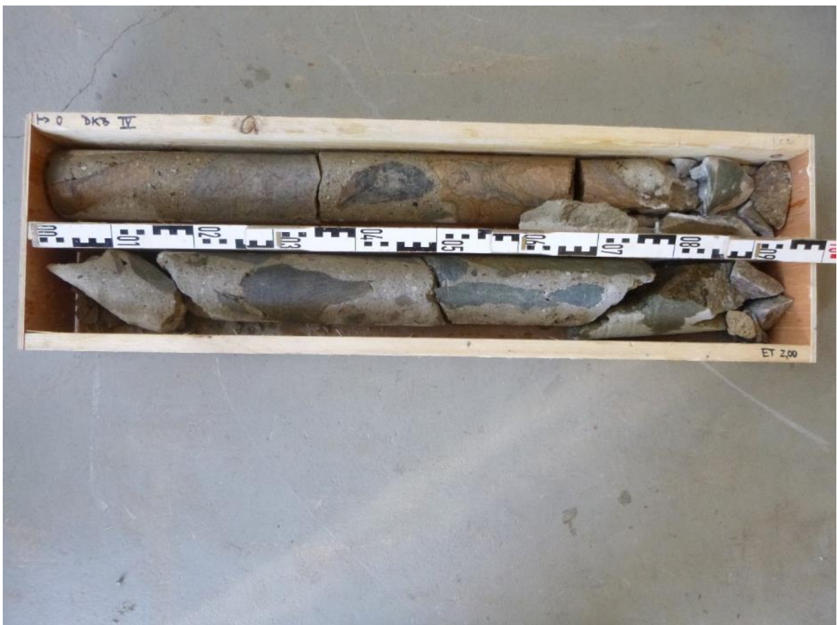
Detail Ansicht Betonbohrkern der Diamantkernbohrung (DKB) Nr. IV
