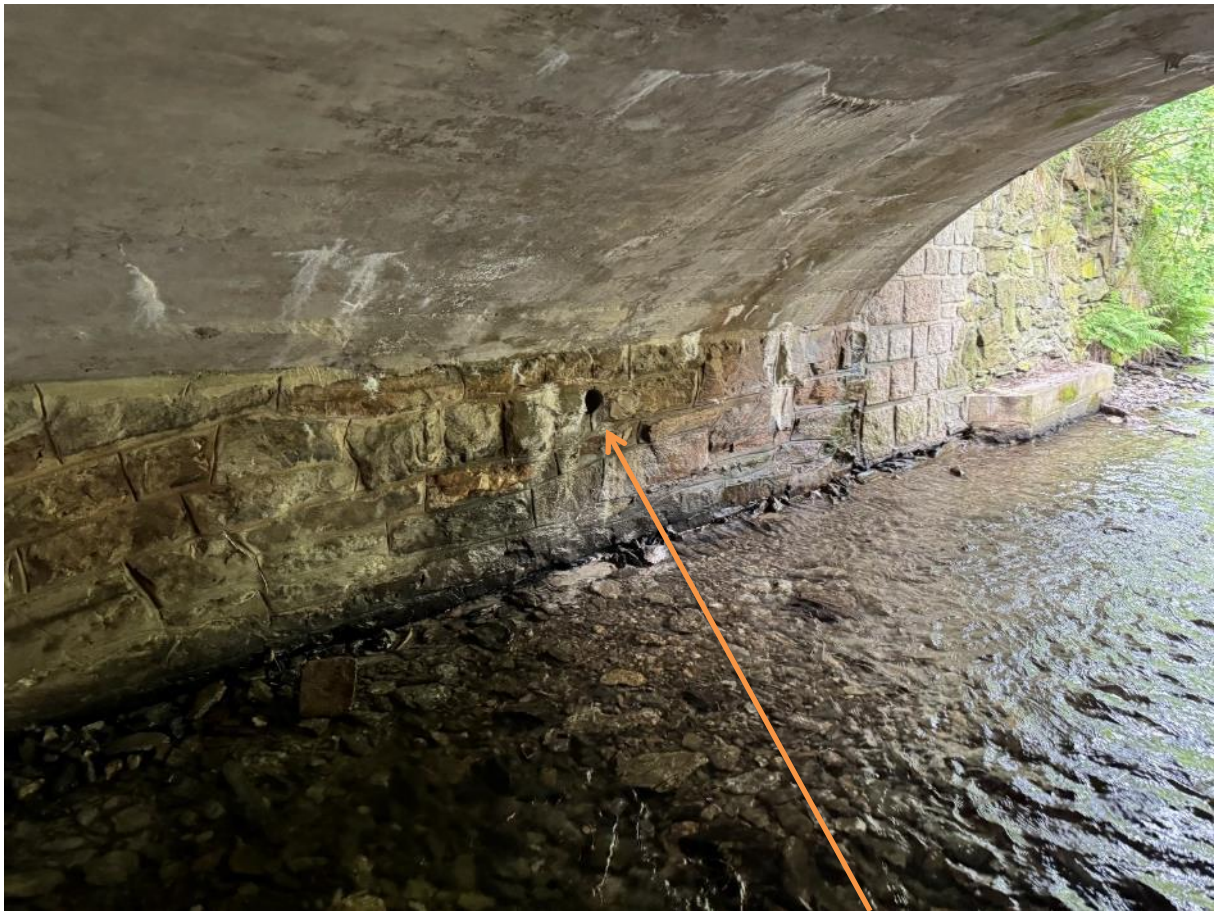
Lage Diamantkernbohrung (DKB) Nr. II
