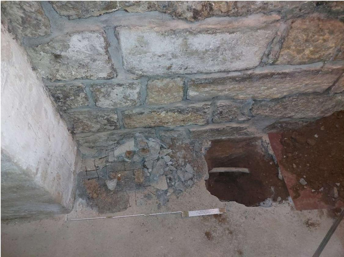
Schurf - Detail mit (Blei-)Rohr, Tiefe und Ansatzpunkt (OF Kellerfußboden)
