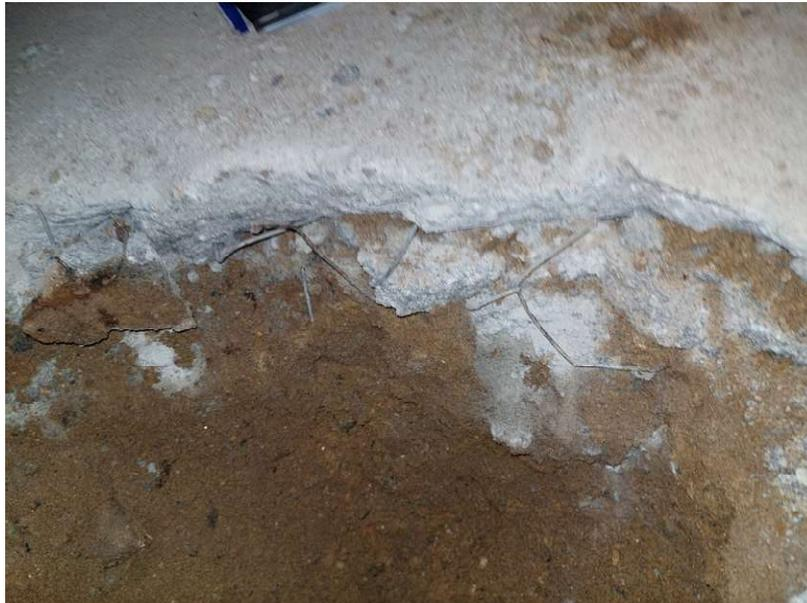
Schurfsohle mit verfestigtem Boden unter Fundamentunterfläche
