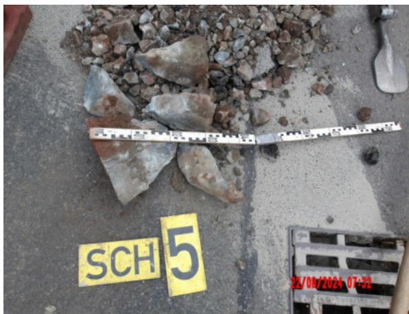
Abb. 27: Detailaufnahme – Packlager, HS 5
