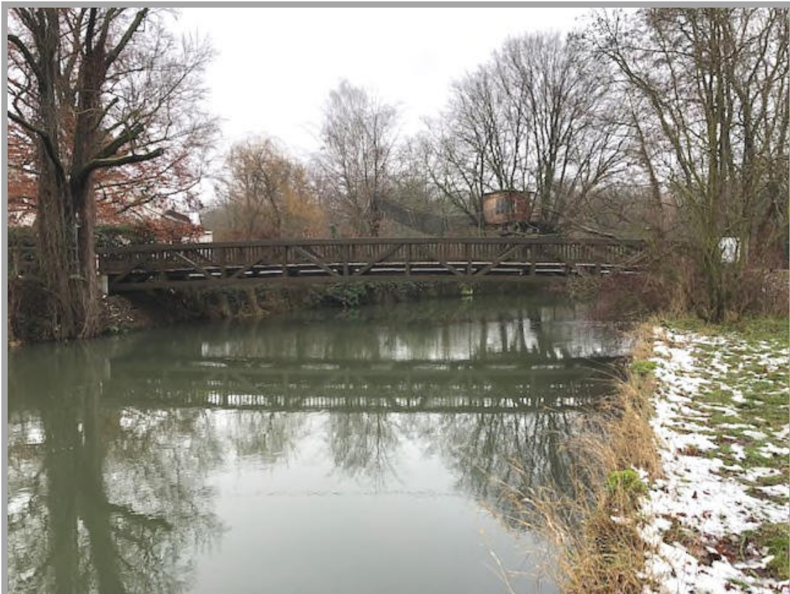
➡ Brücke Schlossweg III über die Weiße Elster (Foto Barthel vom 05.01.2021)
