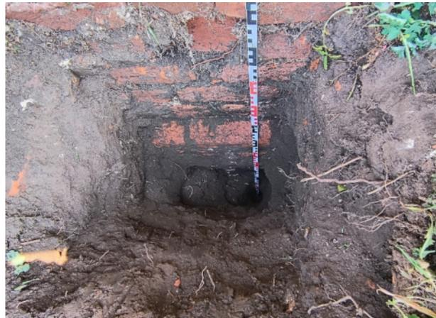
**Abb. 4** Mauerwerksvorsprung in einer Tiefe von 0,53 m unter GOK.
