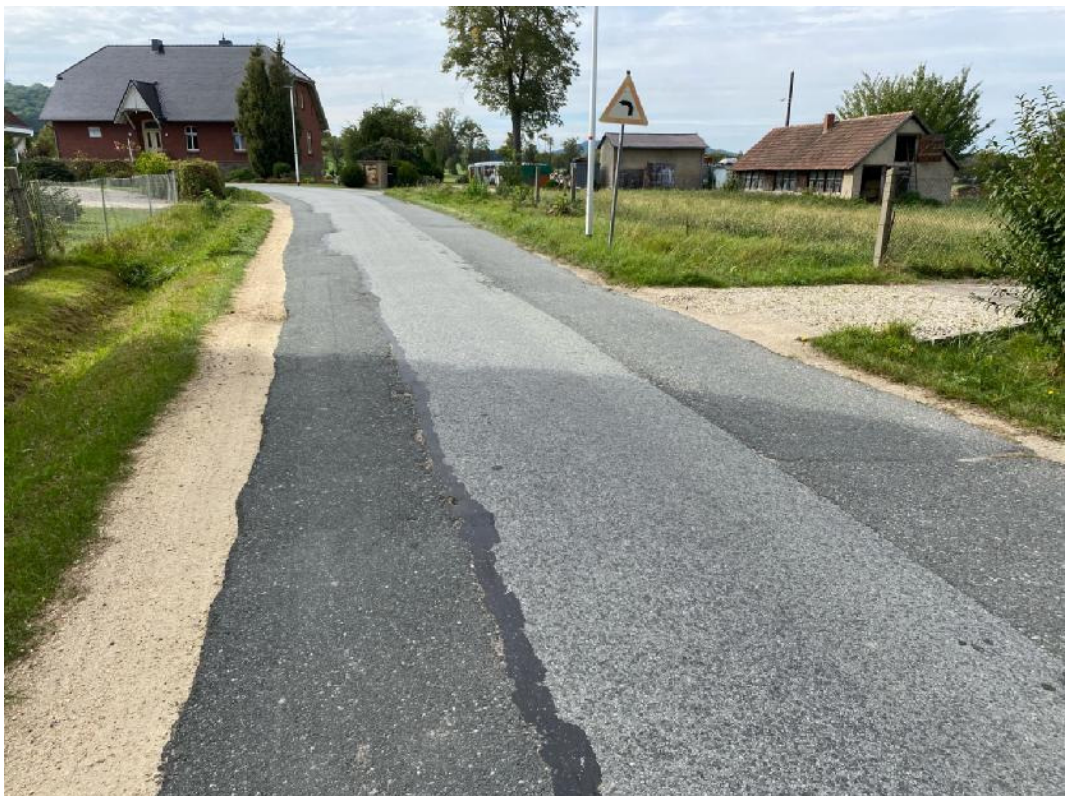
Bild 6: Asphalte Bereich RKS 2
