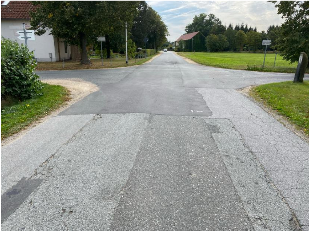
Bild 5: Asphalte Bereich RKS 1
