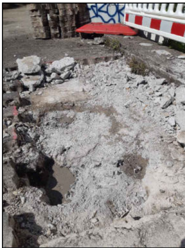
Aufbruch Oberflächenbefestigung mit Verfüllung Durchbruch
