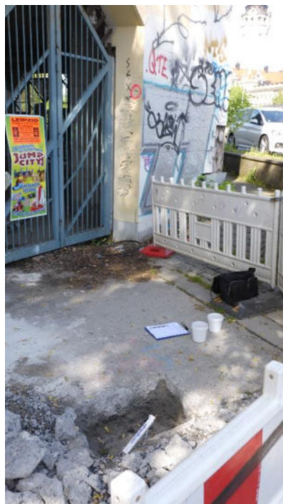
Foto Nr. 4: H-Sch 5/22 Fahrbahnbeton direkt über Gebäudedecke
