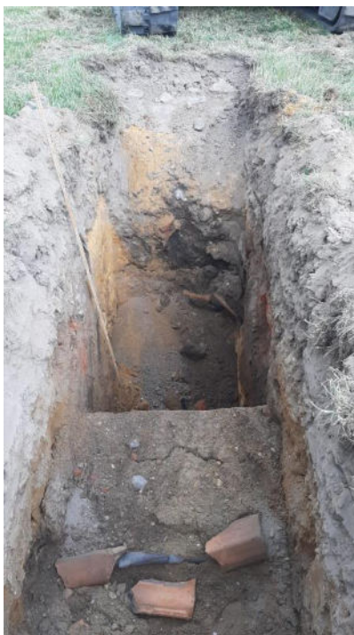
Foto Nr. 33: KB 14/22 freigelegte Altbefestigung
