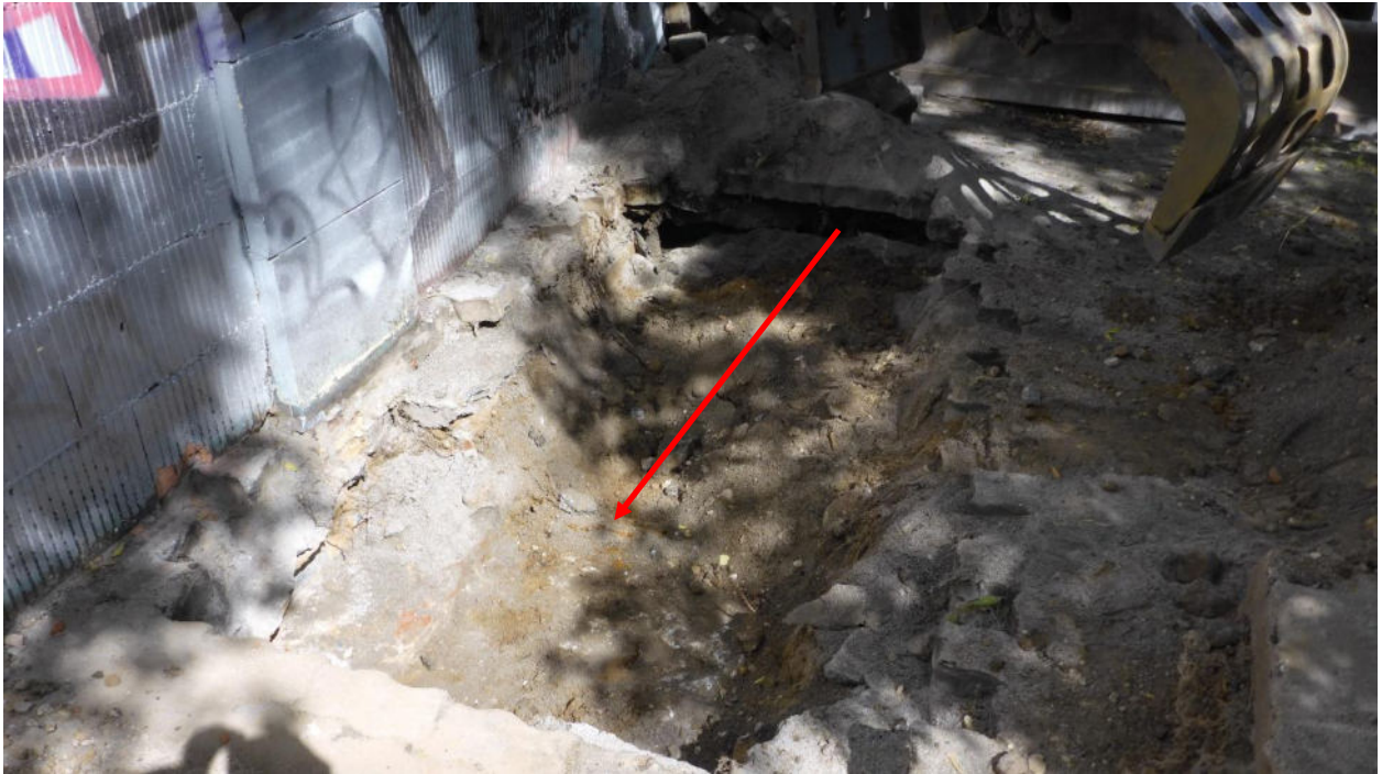
Foto Nr. 17: M-Sch 6/22 Betonauskragungen direkt am Gebäude, Stahlträger (Pfeil)
