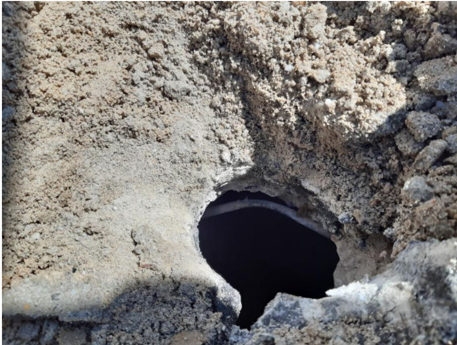
Foto Nr. 29: M-Sch 15/22 Deckendurchbruch durch Meißelarbeit
