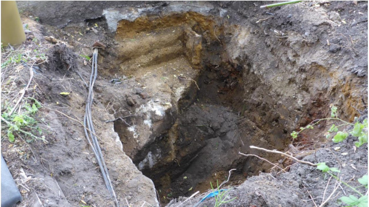
Foto Nr. 15: M-Sch 4/22 mit Stahlträger, Betonauskragungen und Altkabel
