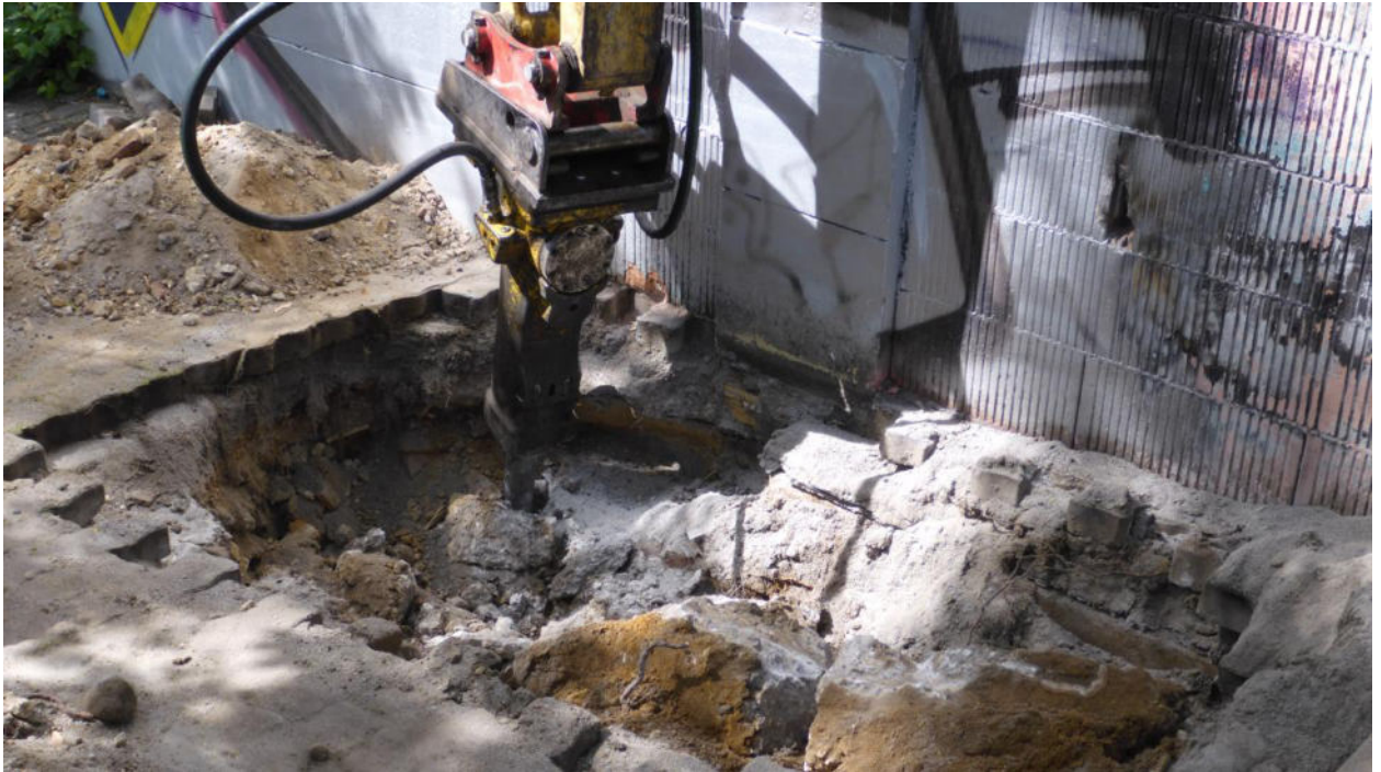
Foto Nr. 19: M-Sch 6/22 Betonabbrucharbeiten
