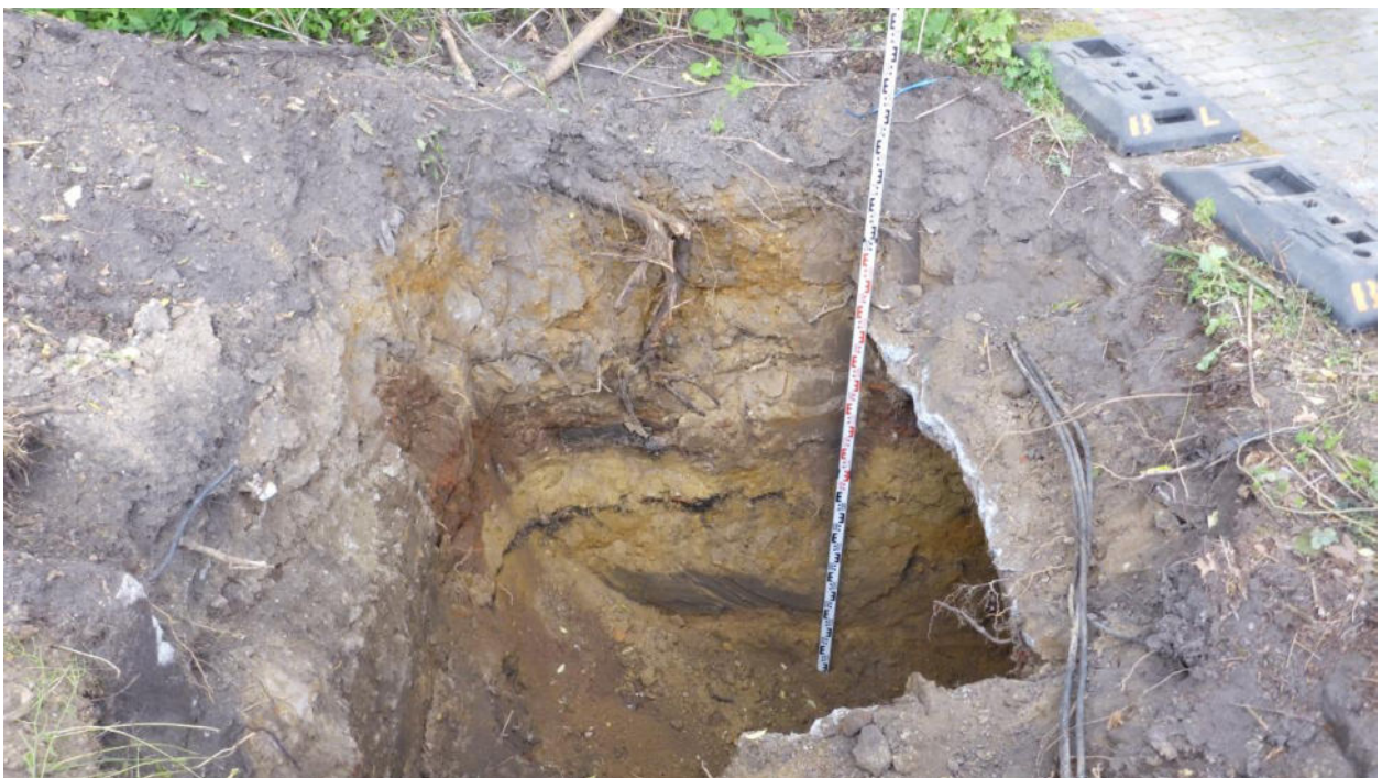
Foto Nr. 16: M-Sch 4/22 Bodenaufbau
