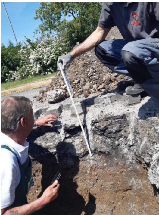
Foto Nr. 24: M-Sch 11/22 Schichtdickenbestimmung
