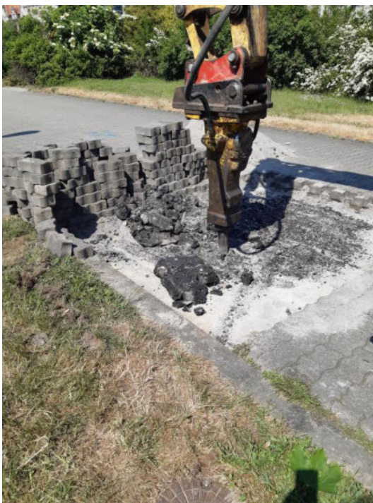
Foto Nr. 23: M-Sch 11/22 Asphaltaufbruch
