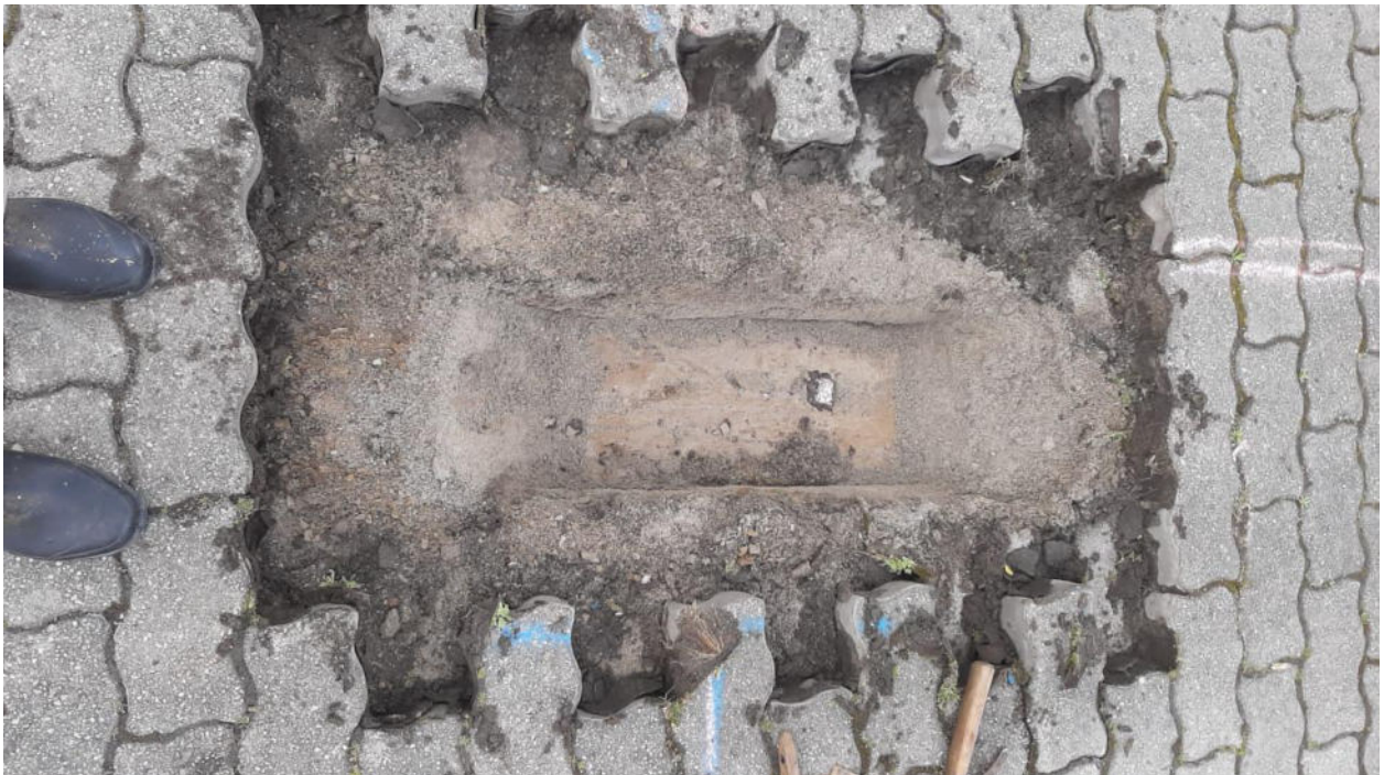
Foto Nr. 30: KB 9/22 aufgenommenes Pflaster, Asphaltsschicht
