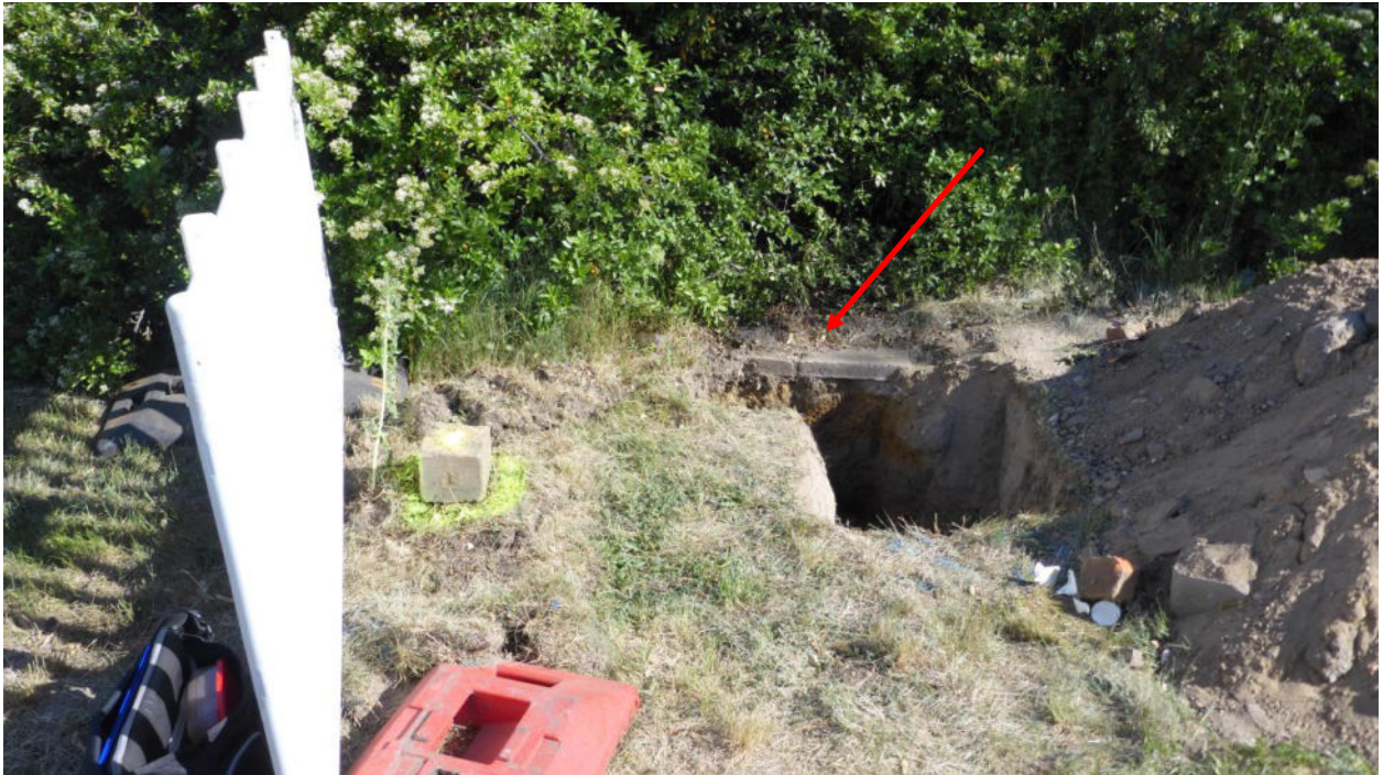
Foto Nr. 1: H-Sch 2/22 im Hintergrund freigelegtes Absperrventil (Pfeil)
