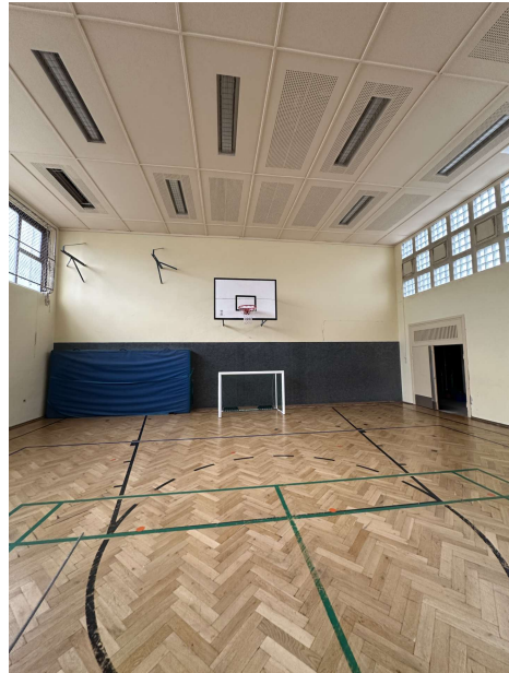
2025-01-14 Innenputz Halle 49. GSSH, Bernhardstraße 80. 014Foto. Ansicht Nord-Ost: Bestandsputz weitestgehend fest, lose Teilbereiche abschlagen und erneuern, Altanstrich schleifen und ggf. grundieren danach Zwischen- und Schlussbeschichtung auftragen.
