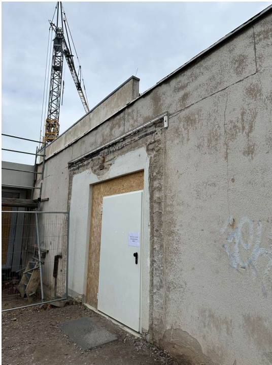
2025-01-14 Objekt- Schulstandort 49. GSSH, Bernhardstraße 80. 005Foto. Ansicht Süd-West: Bestandsputz reinigen, Sockelbereich erneuern, Fremdbauteile entferne und ggf. grundieren. WDVS auf tragfähigen Untergrund kleben
