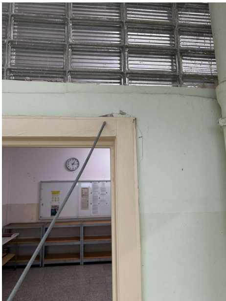
2025-01-14 Funktionsräume 49. GSSH, Bernh rdstr  e 80. 015Foto. Raum 03: mit 3 kleineren Hohlr ngen sollten  bgeschl gen und erneuert werden, Innenputz  nsonsten weitestgehend erh ltenswert
