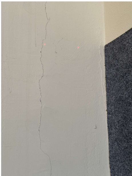
2025-01-14 Innenputz Halle 49. GSSH, Bernhardstraße 80. 027Foto. Ansicht Süd-Ost: Bestandsputz zu 50 Prozent fest, lose Teilbereiche an allen 5 Segmentstützen. Bei diesem Schadensbild wäre ein ganzflächiges erneuern des Oberputzes sinnvoll.
