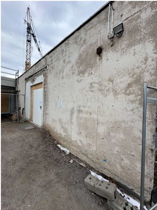
2025-01-14 Objekt- Schulstandort 49. GSSH, Bernhardstraße 80. 001Foto. Ansicht Süd-West: Bestandsputz reinigen, Sockelbereich erneuern, Fremdbauteile entfernen und ggf. grundieren. WDVS auf tragfähigen Untergrund kleben
