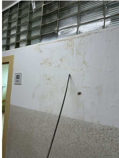
2025-01-14 Funktionsräume 49. GSSH, Bernh rdstr  e 80. 022Foto. G ng: mit 3-4 kleineren Hohl ngen sollten  bgeschl gen und erneuert werden, Innenputz  nsonsten erh ltenswert
