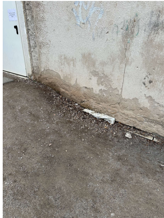
2025-01-14 Objekt- Schulstandort 49. GSSH, Bernhardstraße 80. 006Foto. Ansicht Süd-West: Bestandsputz reinigen, Sockelbereich erneuern, Fremdbauteile entferne und ggf. grundieren. WDVS auf tragfähigen Untergrund kleben
