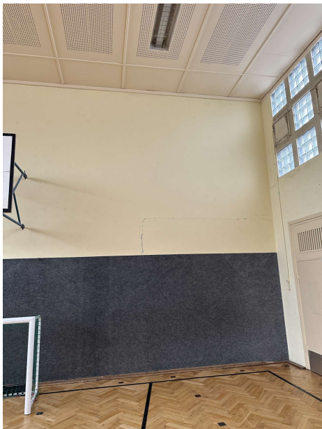
2025-01-14 Innenputz Halle 49. GSSH, Bernhardstraße 80. 015Foto. Teilansicht Nord-Ost: Hohllage mit Rissbildung an gesamter Wandfläche in ca. 2,80 mtr. Höhe über gesamte Wand, lose Teilbereiche abschlagen und erneuern (Rissursache prüfen)
