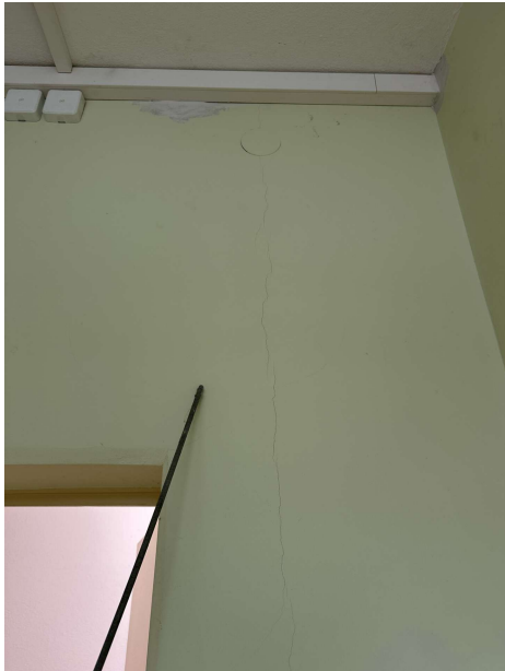
2025-01-14 Funktionsräume 49. GSSH, Bernh rdstr   80. 009Foto. Raum 04: mit einer kleineren Hohl ge, diese sollte  bgeschl gen und erneuert werden, Innenputz  nsonsten erh ltenswert
