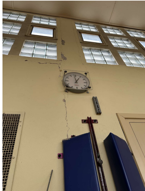
2025-01-14 Innenputz Halle 49. GSSH, Bernhardstraße 80. 022Foto. Ansicht Süd-Ost: Bestandsputz zu 50 Prozent fest, lose Teilbereiche an allen 5 Segmentstützen. Bei diesem Schadensbild wäre ein ganzflächiges erneuern des Oberputzes sinnvoll.
