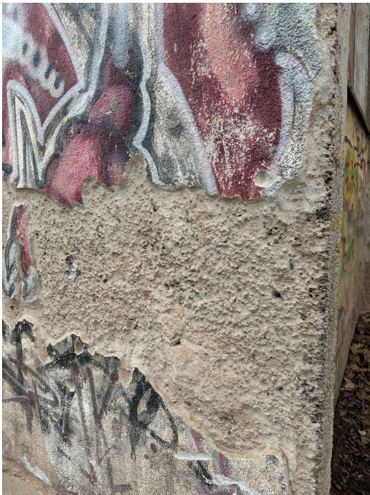
2025-01-14 Objekt- Schulstandort 49. GSSH, Bernhardstraße 80. 015Foto. Ansicht Nord-Ost: Bestandsputz mit Sokelbereich komplett entfernen (Minderfestigkeiten), Sokelbereich, Fremdbauteile entfernen und Ausgleichsputz als Klebefläche auftragen. WDVS auf tragfähigen Untergrund kleben
