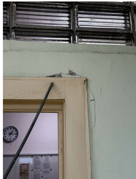
2025-01-14 Funktionsräume 49. GSSH, Bernh rdstr  e 80. 016Foto. Raum 03: mit 3 kleineren Hohlr ngen sollten  bgeschl gen und erneuert werden, Innenputz  nsonsten weitestgehend erh ltenswert
