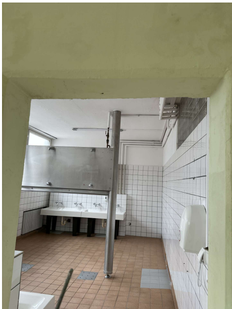
2025-01-14 Funktionsr ume 49. GSSH, Bernh rdstr  e 80. 003Foto. Raum 03: mit W ssersch den und 3 kleineren Hohll gen sollten  bgeschl gen und erneuert werden, Innenputz  nsonsten weitestgehend erh ltenswert
