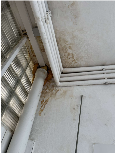
2025-01-14 Funktionsräume 49. GSSH, Bernh rdstr  e 80. 005Foto. Raum 03: mit W ssersch den und 3 kleineren Hohll gen sollten  bgeschl gen und erneuert werden, Innenputz  nsonsten weitestgehend erh ltenswert
