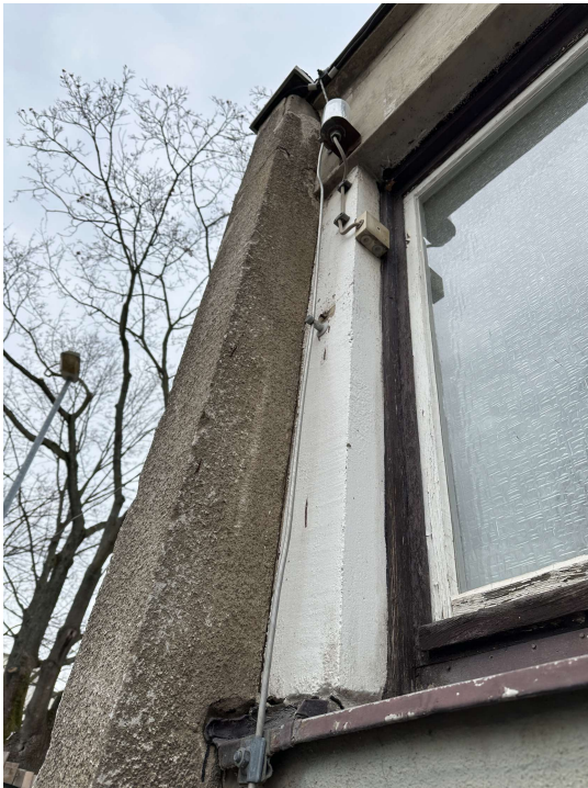
2025-01-14 Objekt- Schulstandort 49. GSSH, Bernhardstraße 80. 009Foto. Ansicht Süd-Ost: Bestandsputz mechanisch reinigen, Sokelbereich Anschluss an Perimeter herstellen, Fremdbauteile entfernen und ggf. grundieren. WDVS auf tragfähigen Untergrund kleben
