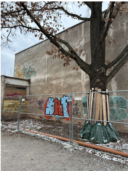
2025-01-14 Objekt- Schulstandort 49. GSSH, Bernhardstraße 80. 019Foto. Ansicht Nord-Ost: Bestandsputz mit Sokelbereich komplett entfernen (Minderfestigkeiten), Sokelbereich, Fremdbauteile entfernen und Ausgleichsputz als Klebefläche auftragen. WDVS auf tragfähigen Untergrund kleben
