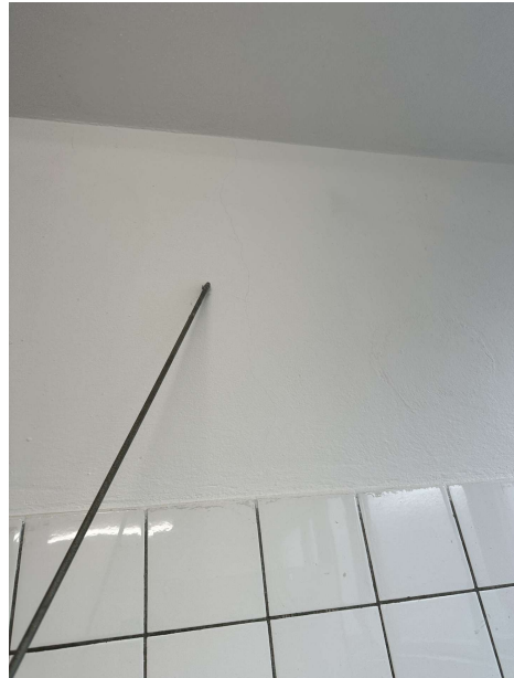
2025-01-14 Funktionsräume 49. GSSH, Bernh rdstr  e 80. 006Foto. Raum 03: mit W ssersch den und 3 kleineren Hohll gen sollten  bgeschl gen und erneuert werden, Innenputz  nsonsten weitestgehend erh ltenswert
