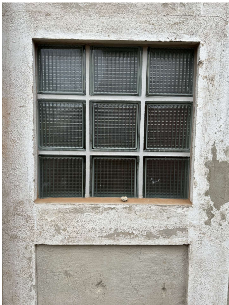
2025-01-14 Innenputz Halle 49. GSSH, Bernhardstraße 80. 003Foto. Ansicht Betonelemente: Altbeschichtungen durch mechanisches schleifen reinigen, Ausbruchstellen erneuern, grundieren sowie neu beschichten
