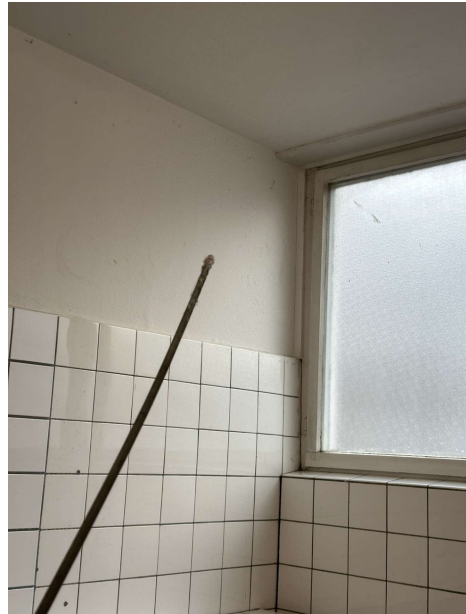
2025-01-14 Funktionsräume 49. GSSH, Bernh rdstr  e 80. 018Foto. Raum 03: mit 3 kleineren Hohll gen sollten  bgeschl gen und erneuert werden, Innenputz  nsonsten weitestgehend erh ltenswert
