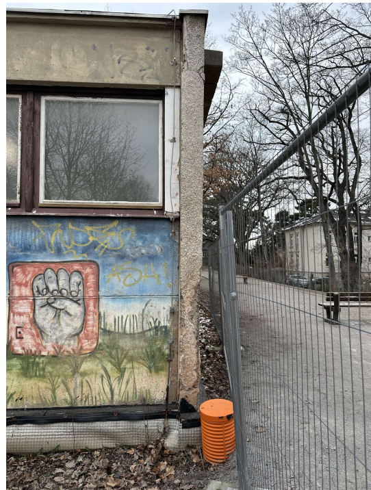
2025-01-14 Objekt- Schulstandort 49. GSSH, Bernhardstraße 80. 012Foto. Ansicht Süd-Ost: Bestandsputz mechanisch reinigen, Sokelbereich Anschluss an Perimeter herstellen, Fremdbauteile entfernen und ggf. grundieren. WDVS auf tragfähigen Untergrund kleben
