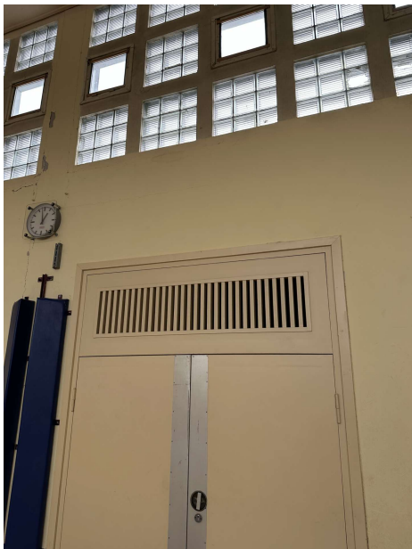
2025-01-14 Innenputz Halle 49. GSSH, Bernhardstraße 80. 023Foto. Ansicht Süd-Ost: Bestandsputz zu 50 Prozent fest, lose Teilbereiche an allen 5 Segmentstützen. Bei diesem Schadensbild wäre ein ganzflächiges erneuern des Oberputzes sinnvoll.
