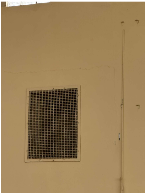
2025-01-14 Innenputz Halle 49. GSSH, Bernhardstraße 80. 019Foto. Ansicht Süd-Ost: Bestandsputz zu 50 Prozent fest, lose Teilbereiche an allen 5 Segmentstützen. Bei diesem Schadensbild wäre ein ganzflächiges erneuern des Oberputzes sinnvoll.
