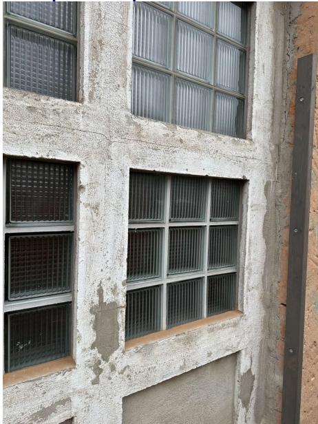
2025-01-14 Innenputz Halle 49. GSSH, Bernhardstraße 80. 001Foto. Ansicht Betonelemente: Altbeschichtungen durch mechanisches schleifen reinigen, Ausbruchstellen erneuern, grundieren sowie neu beschichten
