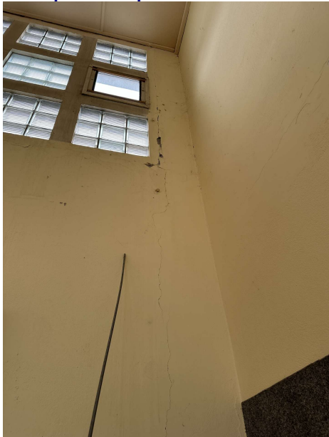
2025-01-14 Innenputz Halle 49. GSSH, Bernhardstraße 80. 025Foto. Ansicht Süd-Ost: Bestandsputz zu 50 Prozent fest, lose Teilbereiche an allen 5 Segmentstützen. Bei diesem Schadensbild wäre ein ganzflächiges erneuern des Oberputzes sinnvoll.
