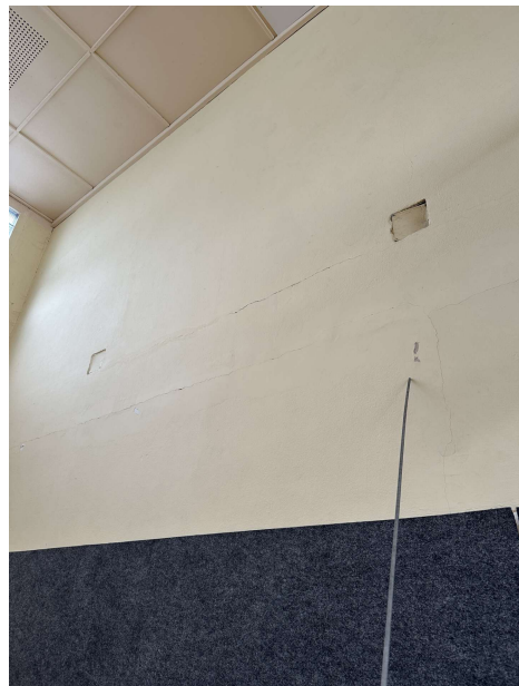
2025-01-14 Innenputz Halle 49. GSSH, Bernhardstraße 80. 012Foto. Teilansicht Süd-West: Bestandsputz Hohllage mit Rissbildung an Wandfläche, lose Teilbereiche abschlagen und erneuern (Rissursache prüfen)
