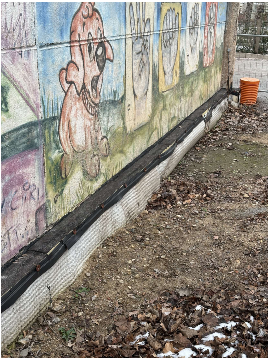
2025-01-14 Objekt- Schulstandort 49. GSSH, Bernhardstraße 80. 011Foto. Ansicht Süd-Ost: Bestandsputz mechanisch reinigen, Sokelbereich Anschluss an Perimeter herstellen, Fremdbauteile entfernen und ggf. grundieren. WDVS auf tragfähigen Untergrund kleben
