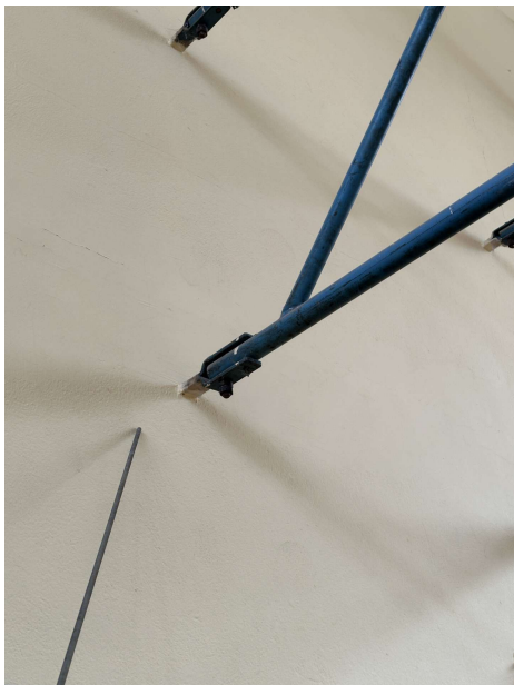
2025-01-14 Innenputz Halle 49. GSSH, Bernhardstraße 80. 011Foto. Teilansicht Süd-West: Bestandsputz Hohllage mit Rissbildung an Wandfläche, lose Teilbereiche abschlagen und erneuern (Rissursache prüfen)
