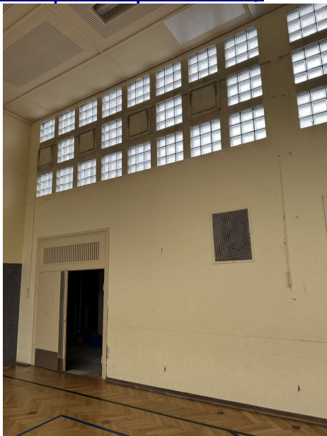
2025-01-14 Innenputz Halle 49. GSSH, Bernhardstraße 80. 017Foto. Ansicht Süd-Ost: Bestandsputz zu 50 Prozent fest, lose Teilbereiche an allen 5 Segmentstützen. Bei diesem Schadensbild wäre ein ganzflächiges erneuern des Oberputzes sinnvoll.
