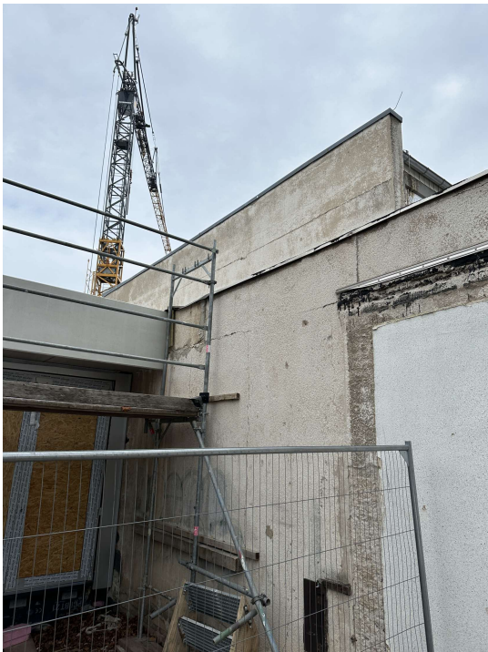
2025-01-14 Objekt- Schulstandort 49. GSSH, Bernhardstraße 80. 003Foto. Ansicht Süd-West: Bestandsputz reinigen, Sockelbereich erneuern, Fremdbauteile entfernen und ggf. grundieren. WDVS auf tragfähigen Untergrund kleben
