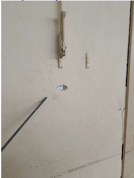
2025-01-14 Innenputz Halle 49. GSSH, Bernhardstraße 80. 021Foto. Ansicht Süd-Ost: Bestandsputz zu 50 Prozent fest, lose Teilbereiche an allen 5 Segmentstützen. Bei diesem Schadensbild wäre ein ganzflächiges erneuern des Oberputzes sinnvoll.
