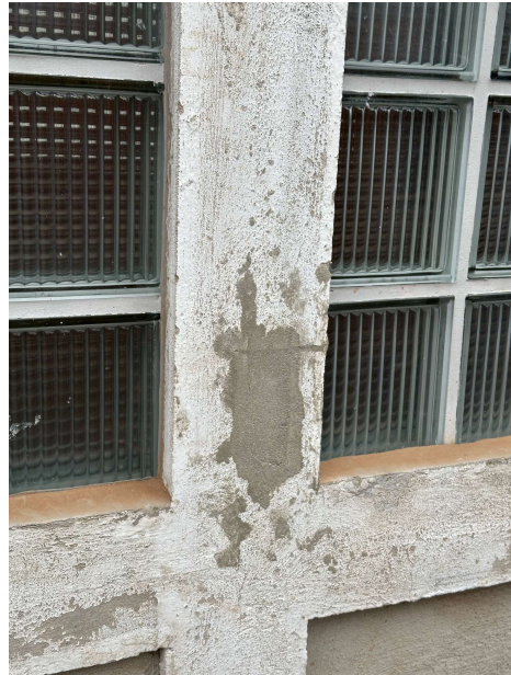
2025-01-14 Innenputz Halle 49. GSSH, Bernhardstraße 80. 002Foto. Ansicht Betonelemente: Altbeschichtungen durch mechanisches schleifen reinigen, Ausbruchstellen erneuern, grundieren sowie neu beschichten
