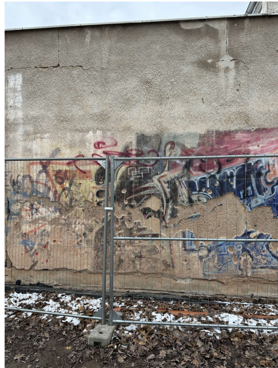
2025-01-14 Objekt- Schulstandort 49. GSSH, Bernhardstraße 80. 014Foto. Ansicht Nord-Ost: Bestandsputz mit Sokelbereich komplett entfernen (Minderfestigkeiten), Sokelbereich, Fremdbauteile entfernen und Ausgleichsputz als Klebefläche auftragen. WDVS auf tragfähigen Untergrund kleben
