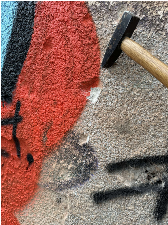
2025-01-14 Objekt- Schulstandort 49. GSSH, Bernhardstraße 80. 017Foto. Ansicht Nord-Ost: Bestandsputz mit Sokelbereich komplett entfernen (Minderfestigkeiten), Sokelbereich, Fremdbauteile entfernen und Ausgleichsputz als Klebefläche auftragen. WDVS auf tragfähigen Untergrund kleben
