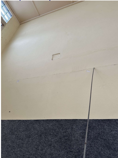
2025-01-14 Innenputz Halle 49. GSSH, Bernhardstraße 80. 013Foto. Teilansicht Süd-West: Bestandsputz Hohllage mit Rissbildung an Wandfläche, lose Teilbereiche abschlagen und erneuern (Rissursache prüfen)
