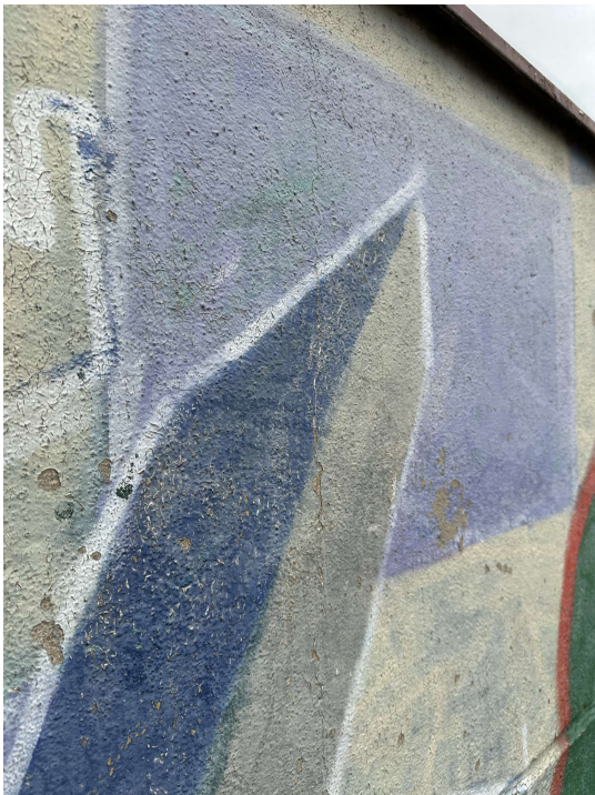
2025-01-14 Objekt- Schulstandort 49. GSSH, Bernhardstraße 80. 007Foto. Ansicht Süd-Ost: Bestandsputz mechanisch reinigen, Sockelbereich Anschluss an Perimeter herstellen, Fremdbauteile entfernen und ggf. grundieren. WDVS auf tragfähigen Untergrund kleben
