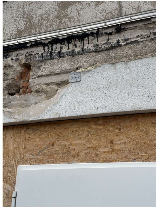
2025-01-14 Objekt- Schulstandort 49. GSSH, Bernhardstraße 80. 004Foto. Ansicht Süd-West: Bestandsputz reinigen, Sockelbereich erneuern, Fremdbauteile entfernen und ggf. grundieren. WDVS auf tragfähigen Untergrund kleben
