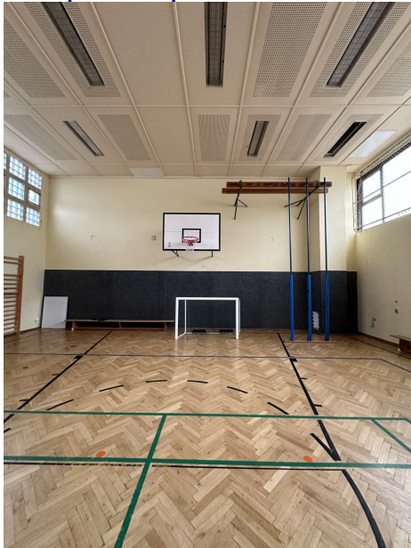
2025-01-14 Innenputz Halle 49. GSSH, Bernhardstraße 80. 005Foto. Ansicht Süd-West: Bestandsputz weitestgehend fest, lose Teilbereiche abschlagen und erneuern, Altanstrich schleifen und ggf. grundieren danach Zwischen- und Schlussbeschichtung auftragen.
