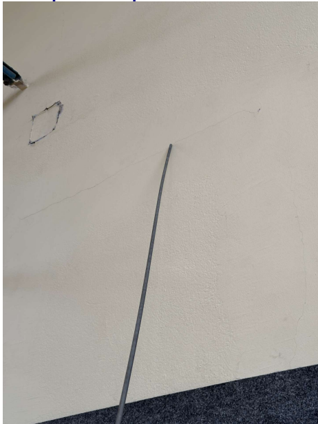
2025-01-14 Innenputz Halle 49. GSSH, Bernhardstraße 80. 009Foto. Teilansicht Süd-West: Bestandsputz Hohllage mit Rissbildung an Wandfläche, lose Teilbereiche abschlagen und erneuern (Rissursache prüfen)
