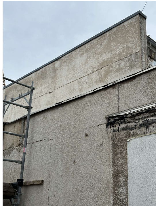
2025-01-14 Objekt- Schulstandort 49. GSSH, Bernhardstraße 80. 002Foto. Ansicht Süd-West: Bestandsputz reinigen, Sockelbereich erneuern, Fremdbauteile entfernen und ggf. grundieren. WDVS auf tragfähigen Untergrund kleben
