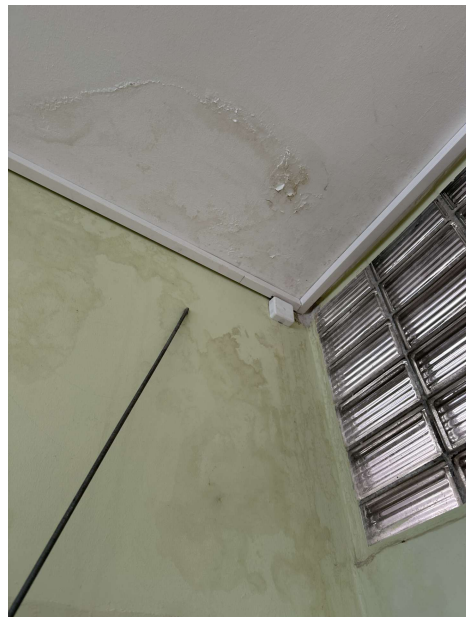
2025-01-14 Funktionsr ume 49. GSSH, Bernh rdstr  e 80. 002Foto. Raum 03: mit W ssersch den und 3 kleineren Hohll gen sollten  bgeschl gen und erneuert werden, Innenputz  nsonsten weitestgehend erh ltenswert
