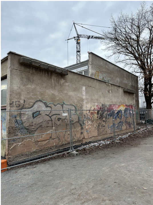
2025-01-14 Objekt- Schulstandort 49. GSSH, Bernhardstraße 80. 013Foto. Ansicht Nord-Ost: Bestandsputz mit Sokelbereich komplett entfernen (Minderfestigkeiten), Sokelbereich, Fremdbauteile entfernen und Ausgleichsputz als Klebefläche auftragen. WDVS auf tragfähigen Untergrund kleben
