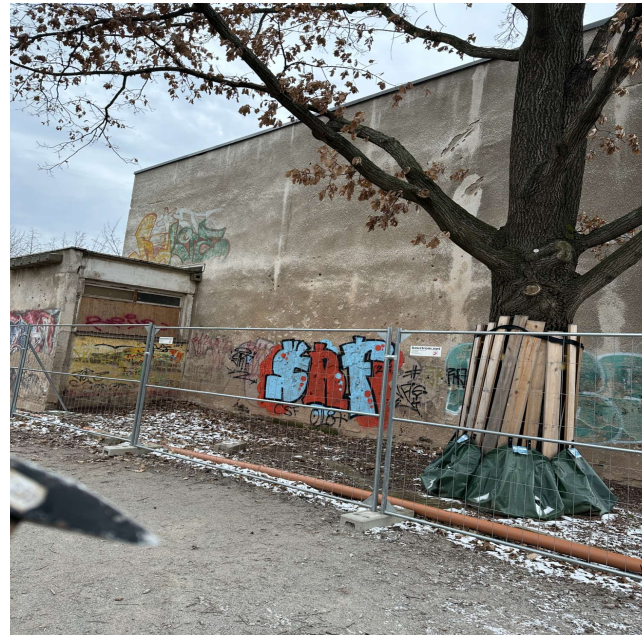
2025-01-14 Objekt- Schulstandort 49. GSSH, Bernhardstraße 80. 018Foto. Ansicht Nord-Ost: Bestandsputz mit Sokelbereich komplett entfernen (Minderfestigkeiten), Sokelbereich, Fremdbauteile entfernen und Ausgleichsputz als Klebefläche auftragen. WDVS auf tragfähigen Untergrund kleben
