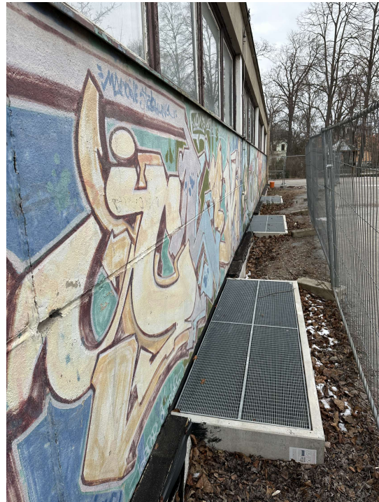
2025-01-14 Objekt- Schulstandort 49. GSSH, Bernhardstraße 80. 010Foto. Ansicht Süd-Ost: Bestandsputz mechanisch reinigen, Sokelbereich Anschluss an Perimeter herstellen, Fremdbauteile entfernen und ggf. grundieren. WDVS auf tragfähigen Untergrund kleben
