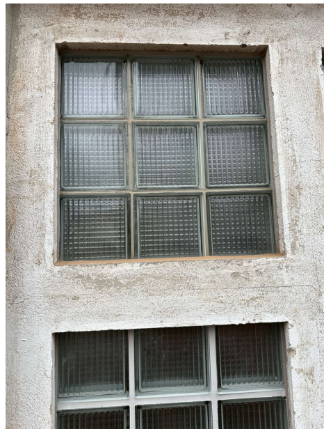
2025-01-14 Innenputz Halle 49. GSSH, Bernhardstraße 80. 004Foto. Ansicht Betonelemente: Altbeschichtungen durch mechanisches schleifen reinigen, Ausbruchstellen erneuern, grundieren sowie neu beschichten
