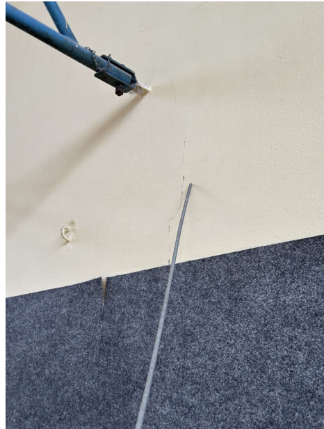
2025-01-14 Innenputz Halle 49. GSSH, Bernhardstraße 80. 010Foto. Teilansicht Süd-West: Bestandsputz Hohllage mit Rissbildung an Wandfläche, lose Teilbereiche abschlagen und erneuern (Rissursache prüfen)
