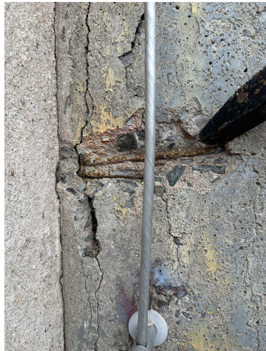
2025-01-14 Objekt- Schulstandort 49. GSSH, Bernhardstraße 80. 016Foto. Ansicht Nord-Ost: Bestandsputz mit Sokelbereich komplett entfernen (Minderfestigkeiten), Sokelbereich, Fremdbauteile entfernen und Ausgleichsputz als Klebefläche auftragen. WDVS auf tragfähigen Untergrund kleben
