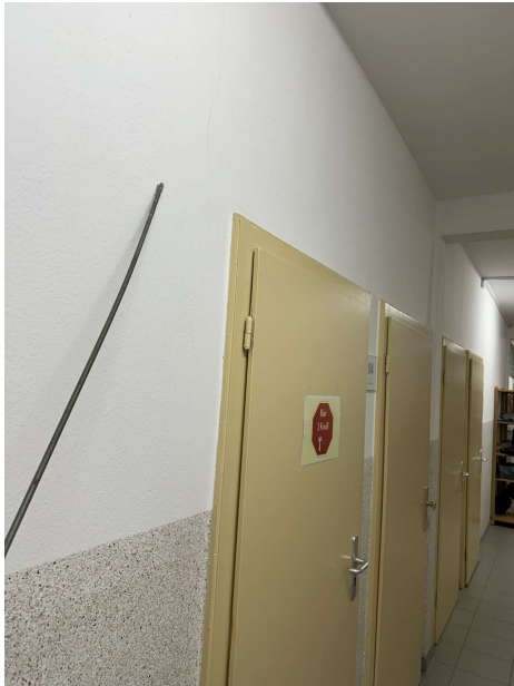
2025-01-14 Funktionsräume 49. GSSH, Bernh rdstr  e 80. 021Foto. G ng: mit 3-4 kleineren Hohl ngen sollten  bgeschl gen und erneuert werden, Innenputz  nsonsten erh ltenswert
