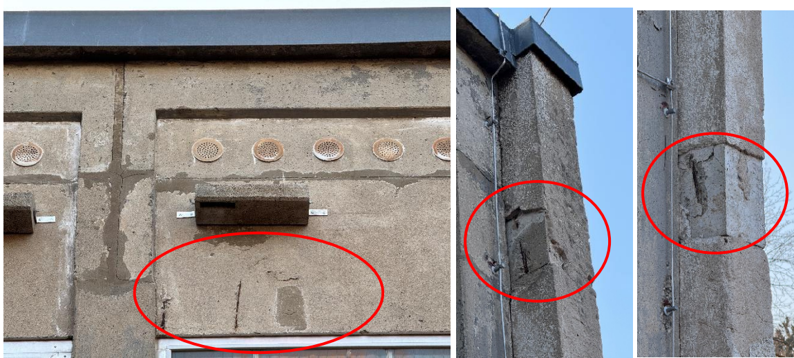
Abbildung 7: Anschließende Bauteile: Riegel (links), Ringbalken 1 (Mitte) und Ringbalken 2 (rechts)
