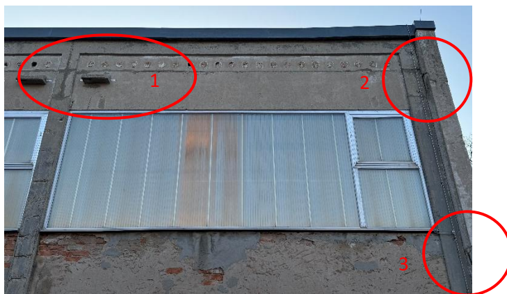
Abbildung 6: Anschließende Bauteile: Riegel (1), Ringbalken 1 (2) und Ringbalken 2 (3)
