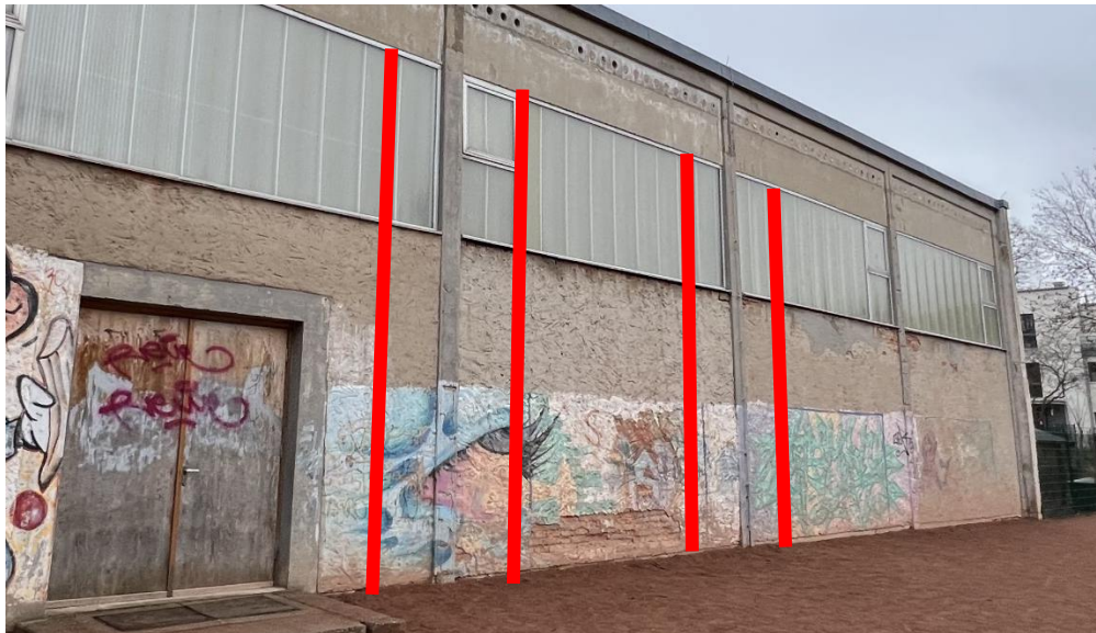
Abbildung 14: Prinzipskizze Abfangung mit Schwerlaststützen
