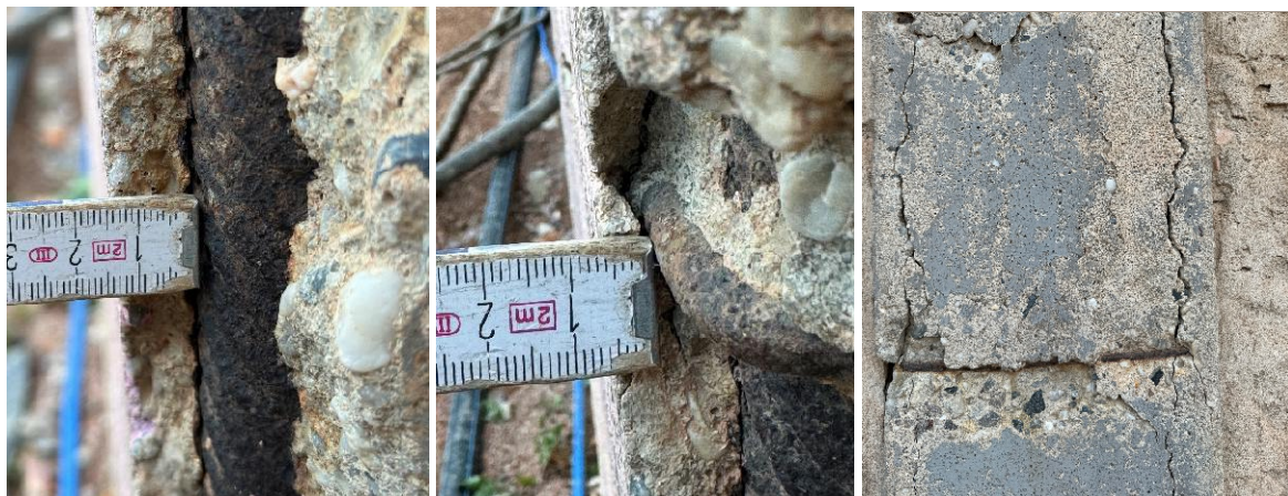
Abbildung 3: Betondeckung Längsbewehrung (links) und Bügel (mitte), Beschichtungsreste (rechts)
