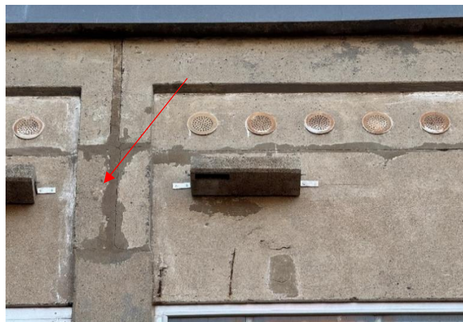
Abbildung 10: Fertigteilfugen, teilweise gerissen und lose
