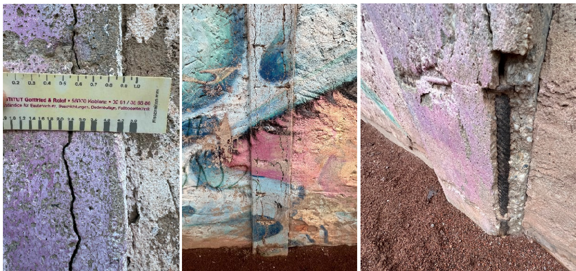
Abbildung 5: Stahlbetonstützen mit freiliegender Bewehrung und Rissen/Betonabplatzungen
