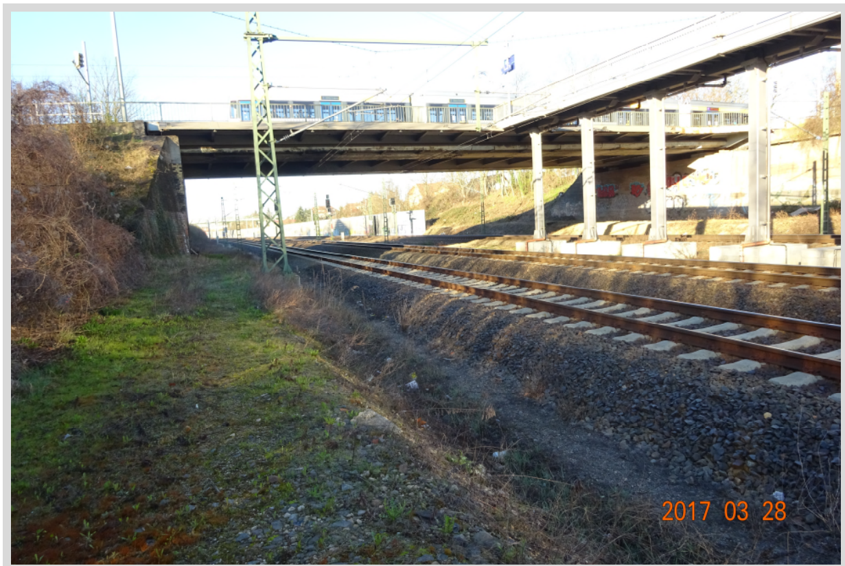
➡ derzeitige Georg-Schwarz-Brücke - Bauwerk 1 / Ansicht vom Gleisniveau - Blicke von Ost nach West (Foto Barthel vom 28.03.2017)
