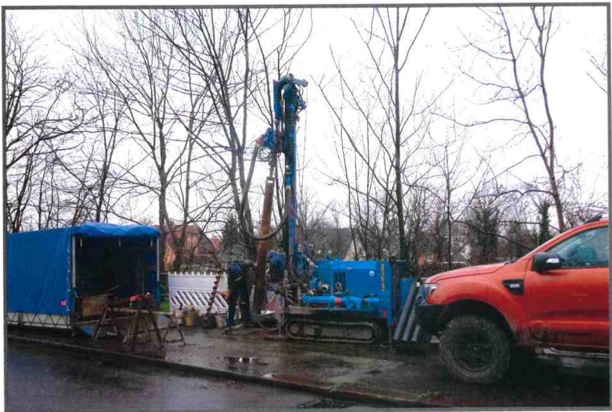
➤ Bohrrgerät auf dem Bohrpunkt RKB 3/20 an der Ludwig-Huffeld-Straße am 0.3.03.2020
