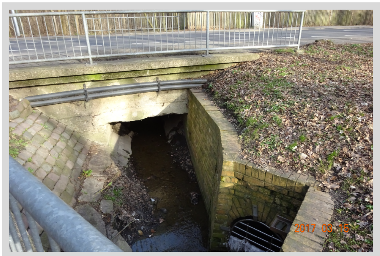
➡ derzeitige Brücke „Am Forsthaus“ über den Bauerngraben von West nach Ost (Foto Barthel vom 15.03.2017).
