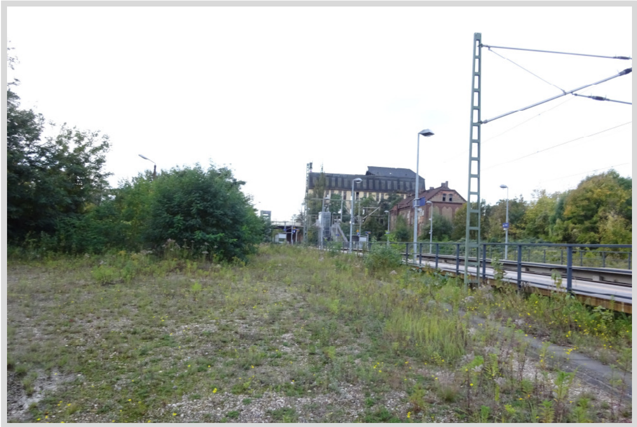
➡ Baubereich des südlichen Treppenturms der Behelfsbrücke südlich Bahnstrecke 6383 Blick von Ost nach West (Foto Barthel vom 28.03.2017)
