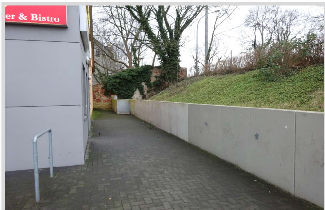
➡ nördlicher Baubereich der Stützwand 3 / vorhandene Stützwand Netto-Markt (Foto Barthel vom 16.01.2018)
