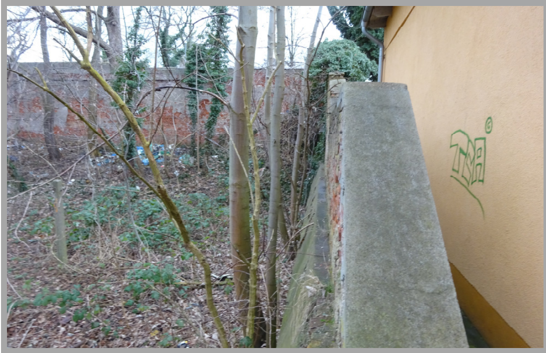
➡ südlicher Baubereich der Stützwand 3 / östlich der Stützwand an der Leipziger Straße (Foto Barthel vom 16.01.2018)
