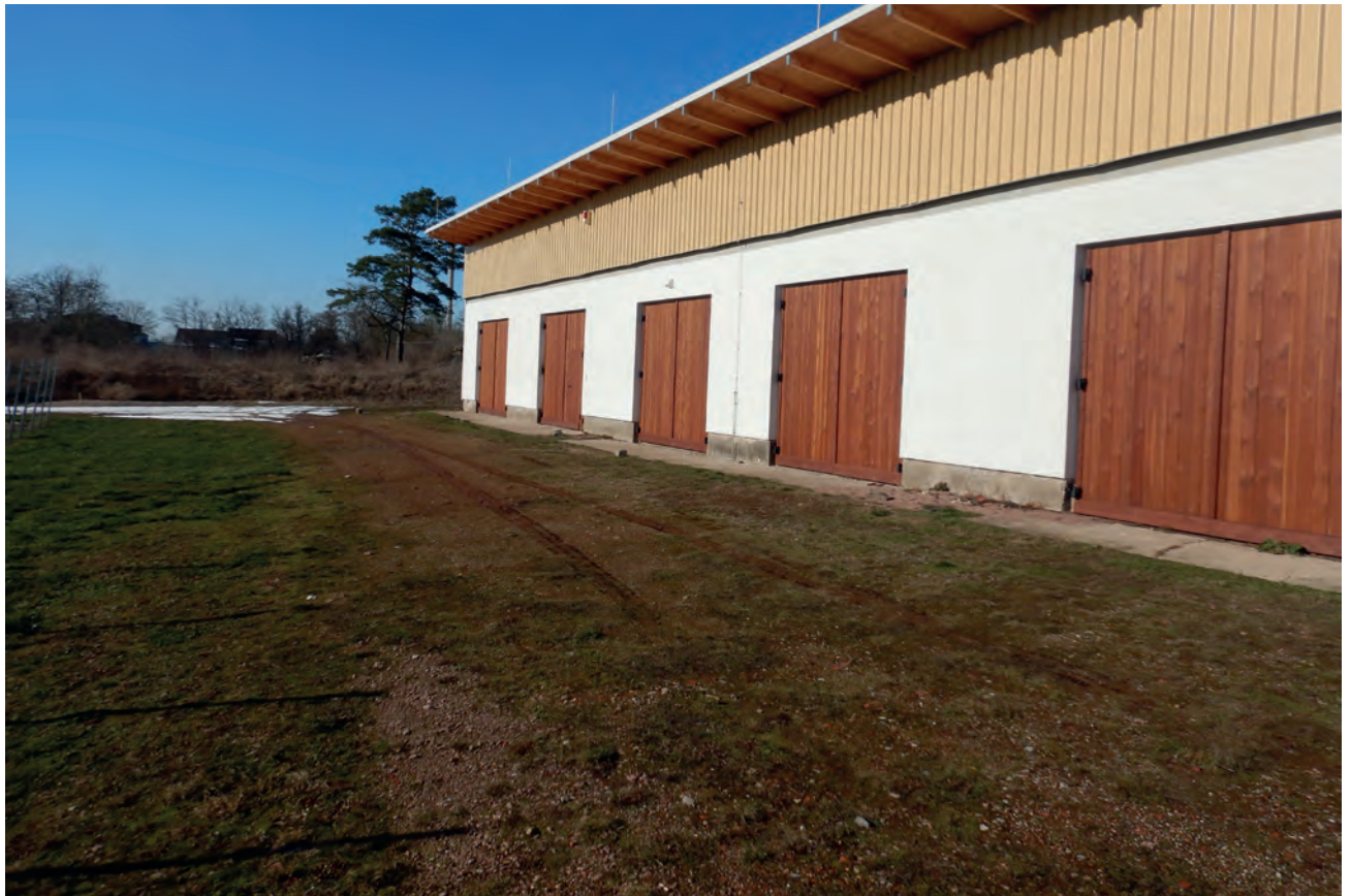
Abb. 03 - vorhandene Baustraße und Weinberg-Garagen
