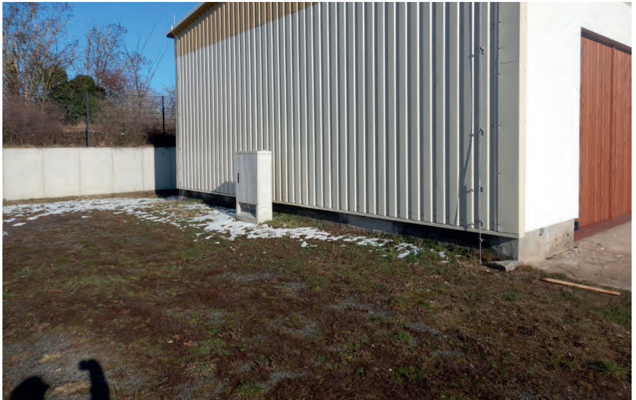
Abb. 05 - Verteilerschrank Bestand, herstellen von Traufstreifen
