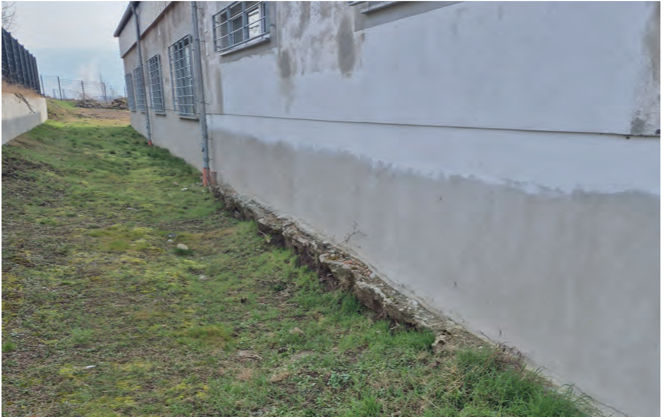
Abb. 07 - rückwärtiger Bereich, zukünftiger Traufstreifen und Rasenfugenpflaster; Betonabbruch als Handabbruch Pos. 01.01.4
