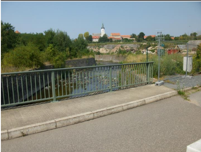
Bild 1 Anfang Leistungsabschnitt 1 (Weesensteiner Straße, Dohna)
