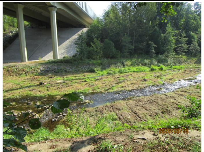
Bild 2 Ende Leistungsabschnitt 1/ Anfang Leistungsbereich 2 (Autobahnbrücke)
