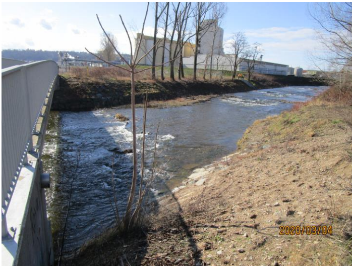
Bild 3 Ende Leistungsbereich 2 (Radbrücke Mündung Elbe)
