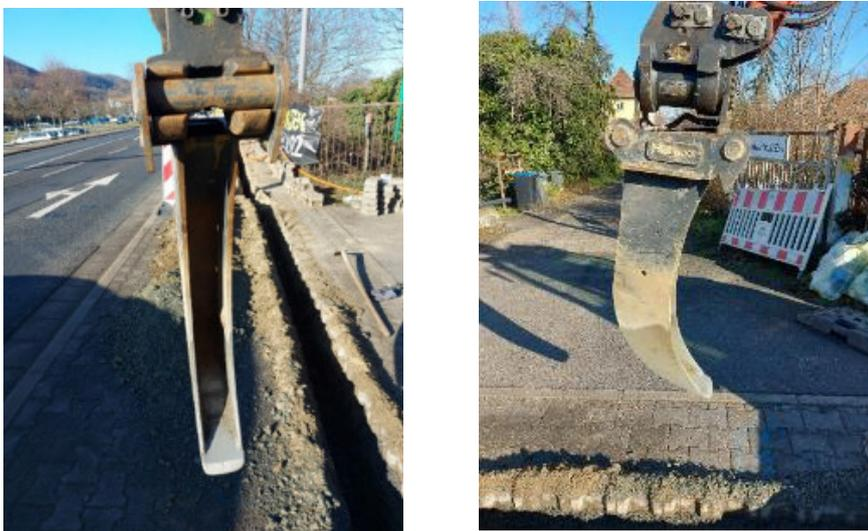
Die Grubengröße zur Montage von Muffen und Schächte ist unverändert. Bei Gräben mit verringerter Mindesttiefe und der Grabenbreite von 15 cm ist keine Montage im Graben zulässig. Die Leerrohre sind fertig vorzubereiten und montiert in der Grabensohle auszulegen. Maschinelle Verdichtungsgeräte dürfen erst nach einer Überdeckung von 30 cm verwendet werden.
