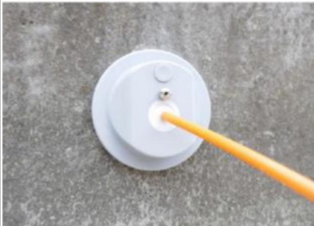
**Bild 33– Mehrfachmauerdurchführung (außen)**
