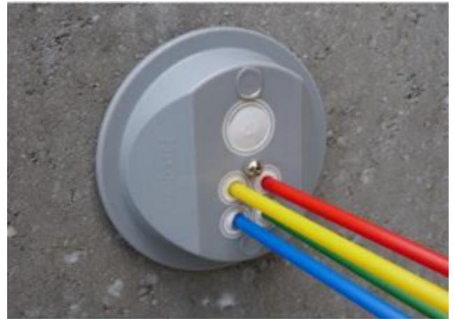
Die Installation der jeweiligen Mauerdurchführung hat grundsätzlich nach Herstellerangaben zu erfolgen. In Einzelfällen können nach Absprache mit dem Hauseigentümer Mehrsparten-Hauseinführungen genutzt werden. Hinsichtlich des vorbeugenden Brandschutzes ist zu beachten, dass nach der Hauseinführung im Gebäude unverzüglich von Außenkabel und Mikrorohr auf Indoor zugelassene Materialien umgesetzt werden muss.
