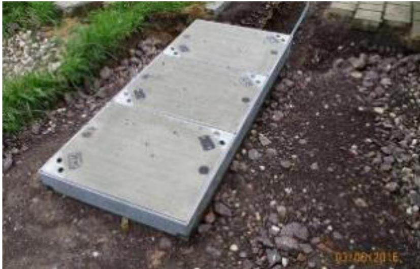
**Bild 25 – Schacht EK 648 im Auslieferungszustand**
