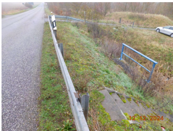
2024H-14_BÖSCHUNG RECHTS_GERINGER BEWUCHS
