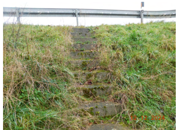
2024H-12_BÖSCHUNGSTREPPE LINKS_BEWUCHS_BEMOOST
