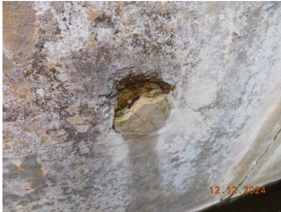
2024H-05_FLÜGEL VORN RECHTS_ROST_BETON LOCKER
