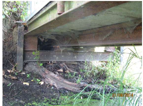
2014H_04_WIDERLAGERKONSTRUKTION HINTEN ANGERÖSTET
