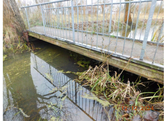
2024H-01_LÄNGSTRÄGER LINKS STARK ANGERÖSTET
