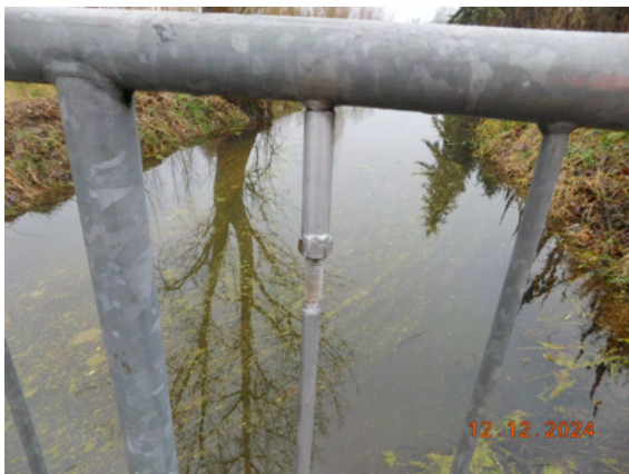
2024H-06_GELÄNDER RECHTS MITTE_INSTANDSETZUNG FÜLLSTAB
