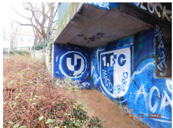
2024H-02_WIDERLAGER VORN RECHTS_FLÄCHENDECKEND FÄRBE
