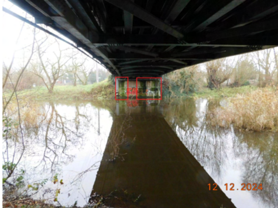
2024H-03_WIDERLAGER HINTEN_STARK BEMOOST
