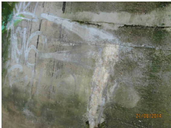
2014H_35_WIDERLAGER HINTEN RECHTS AUSSINTERUNGEN
