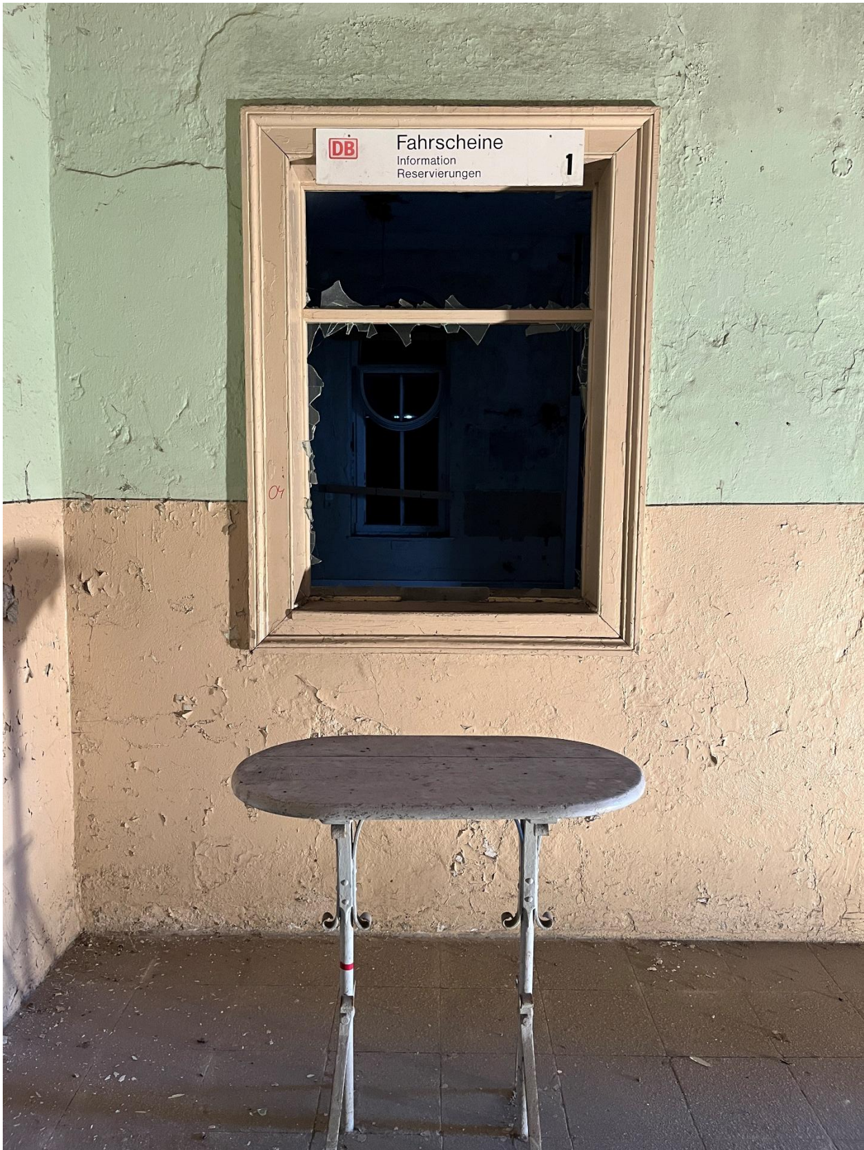
Foto 1: Ehemaliger Fahrkartenschalter mit davor stehendem Ablagetisch
