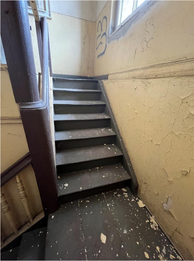
Foto 3: Bestandstreppe, dritter Lauf bis ins Obergeschoss
