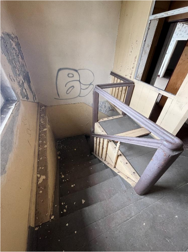
Foto 5: Bestandstreppe, Blick vom Obergeschoss nach unten
