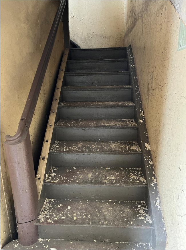
Foto 1: Bestandstreppe, erster Lauf bis erstes Zwischenpodest
