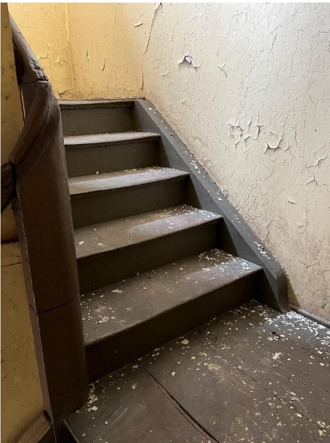
Foto 2: Bestandstreppe, zweiter Lauf bis zweites Zwischenpodest
