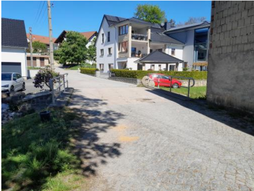
Foto 1: Bestandsbauwerk Blickrichtung von Ost
