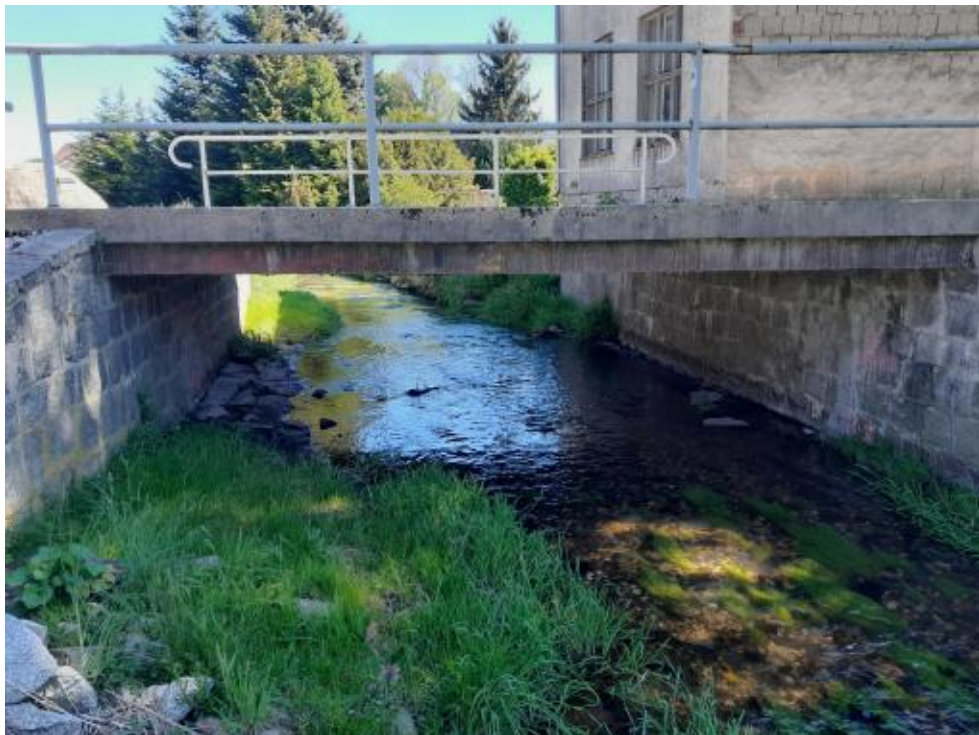
Foto 2: Bestandsbauwerk Blickrichtung von Süd
