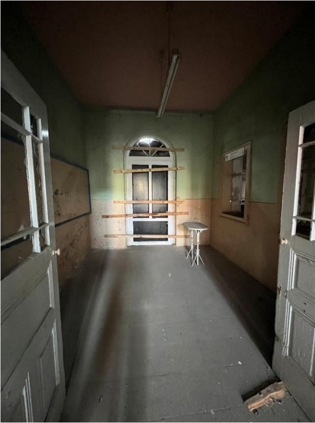
Foto 5: Foto des Durchgangsraumes, Südseite; Blickrichtung Süden
