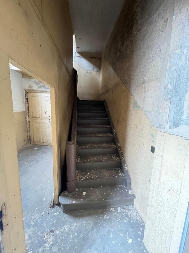
Foto 7: Foto des Treppenraumes, erster Lauf der Treppe in Obergeschoss (Innenwände jüngeren Datums werden alle abgebrochen)
