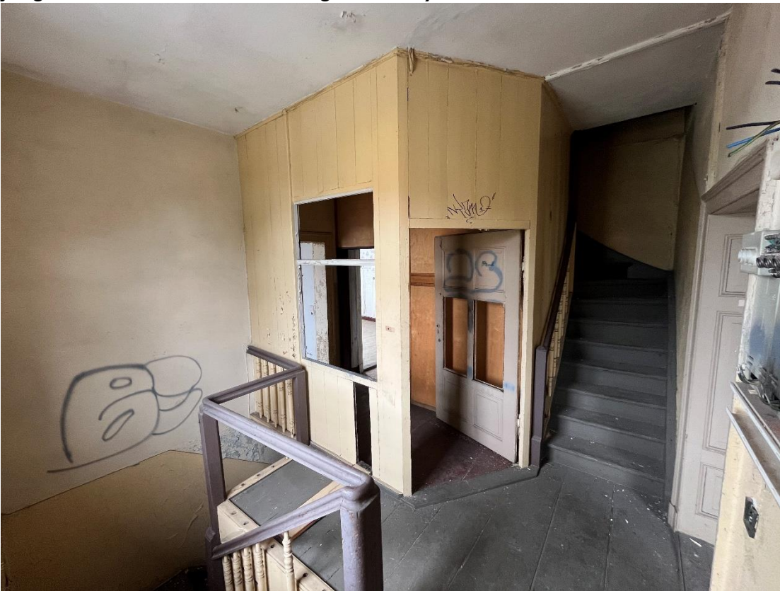
Foto 8: Foto des Treppenraumes, Obergeschoss, Abbruch der Innenwände jüngeren Datums, Abbruch der Treppe ins Dachgeschoss
