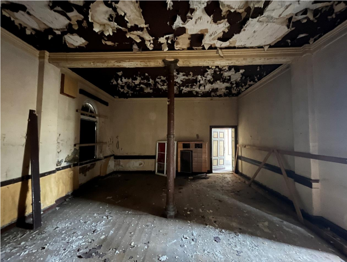
Foto 3: Foto der historischen Gussstütze im ehemaligen Speiseraum mit dem darüber liegendem Holzbalken
