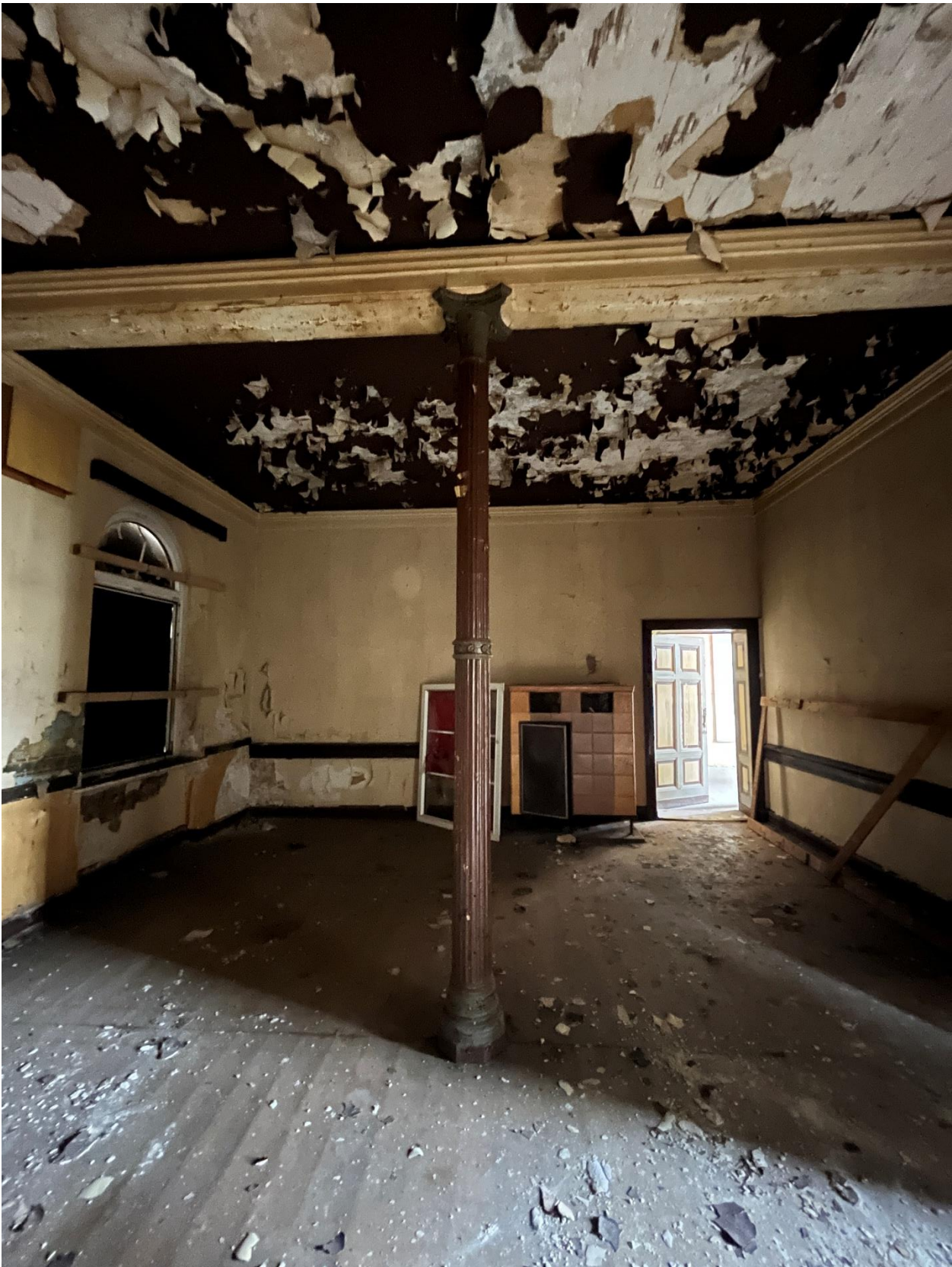
Foto 2: Foto der historischen Gussstütze im ehemaligen Speiseraum
