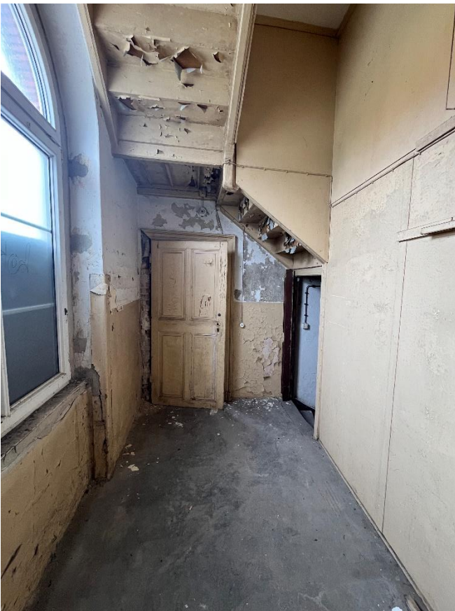
Foto 6: Foto des Treppenraumes, links im Bild die nördliche Außenwand
