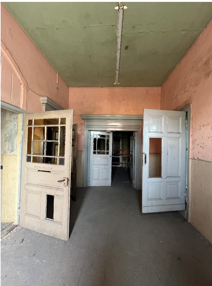
Foto 4: Foto des Durchgangsraumes, Nordseite; Blickrichtung Süden
