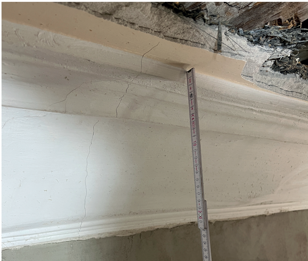
Teilweise sind auch Nachbesserungen mit Mörtel erkennbar
