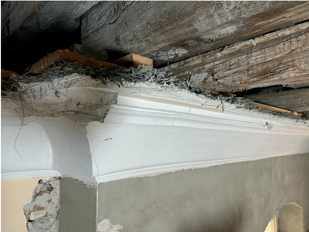
Das Gesims besteht aus Zementkalkmörtel (Grauzug) mit einer unterschiedlich dicken Schicht Gips (Weißzug)
