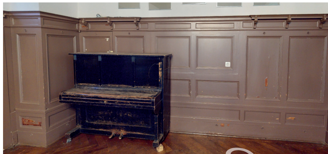
1. größere und kleinere Schadstellen am Lambris an der Nordwand
