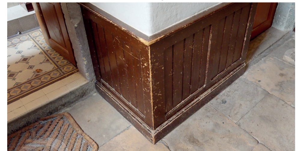
3. Erhebliche Abnutzungen an den Ecken. Lambris ausarbeiten für Türelement. Siehe Detail A-191 Türanschluss
