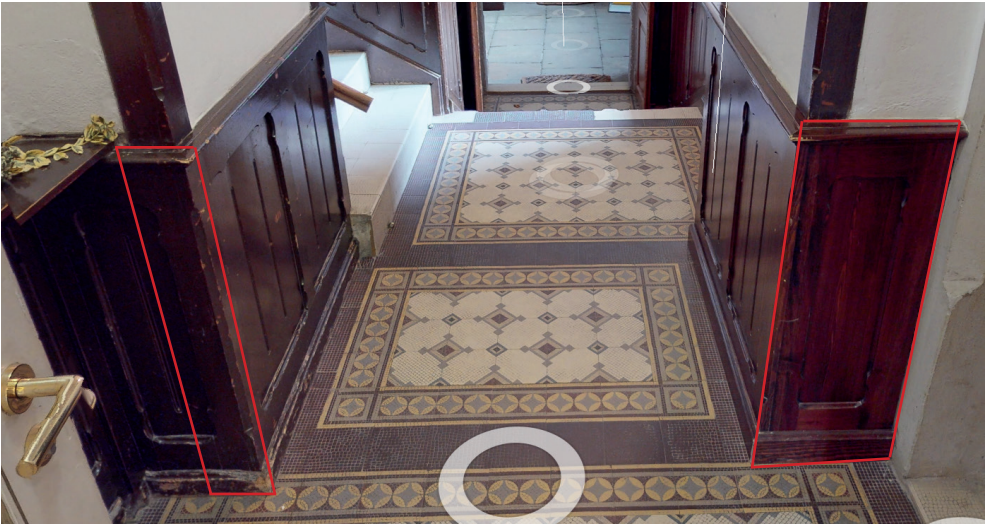
3. Ausarbeiten Holzlambris zum Einbau des Scherengitter. Siehe Detail A-127
