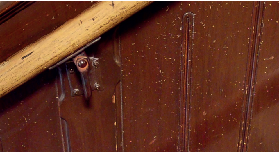
2. wiederkehrendes Schadensbild am Holzlambris Metallelemente RAL 8022
