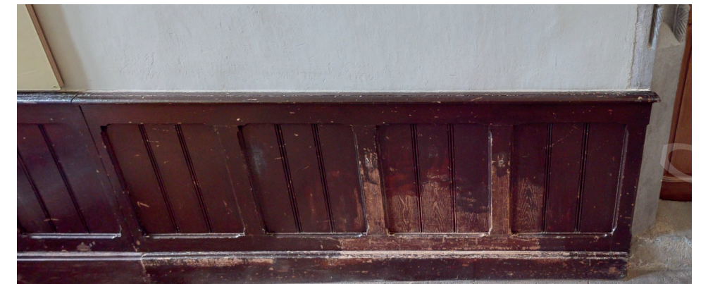
1. Schaden an der Endbeschichtung, identisch mit Schadprofil gegenüber
