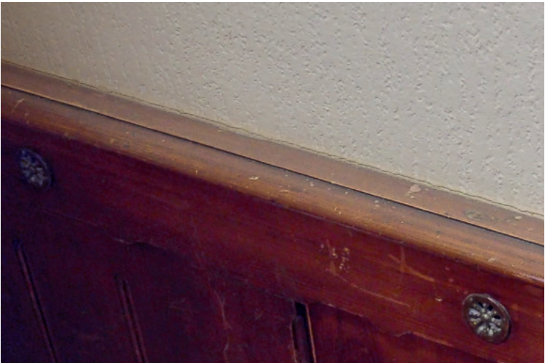
2. Lambris mit Belüftungselementen
