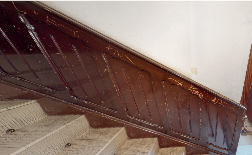
1. Ritzungen im Holzlambris, Anarbeitung an die Stufen
