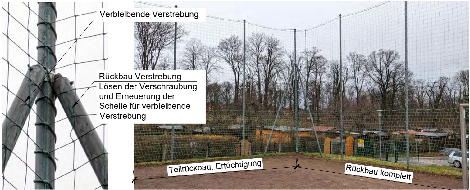
Befestigung Verstrebung an Eckpfosten
