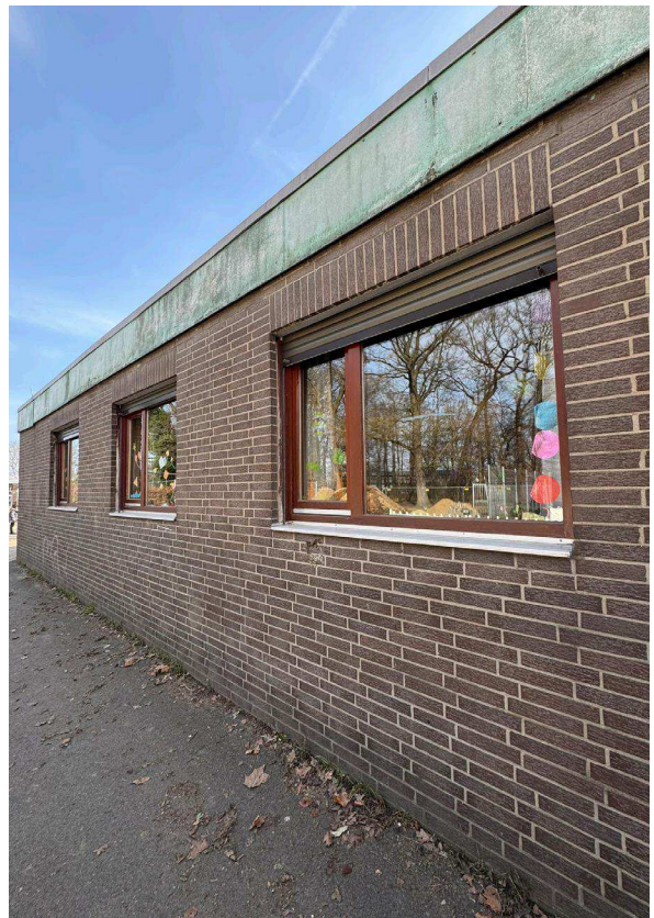
Schützenhaus Fassade Nord-West
