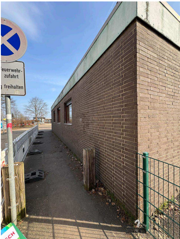
Schützenhaus Fassade Nord-West
