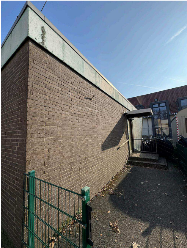
Schützenhaus Haupteingang Fassade West
