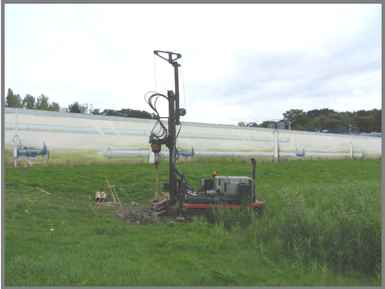
➤ Bohrgerät auf dem Aufschlusspunkt TKB 19 / Baubereich des geplanten Belebungsbeckens E, im Hintergrund das Belebungsbecken D (Foto EBL GmbH vom 19.09.2015)
