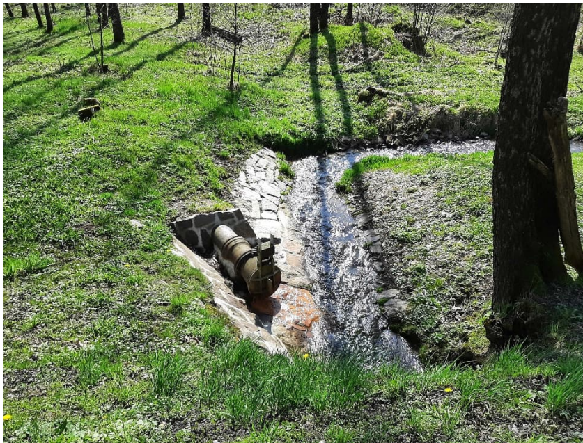
Abbildung 3: Einmündung Entleerungsleitung von Schacht O in den Rossbach
