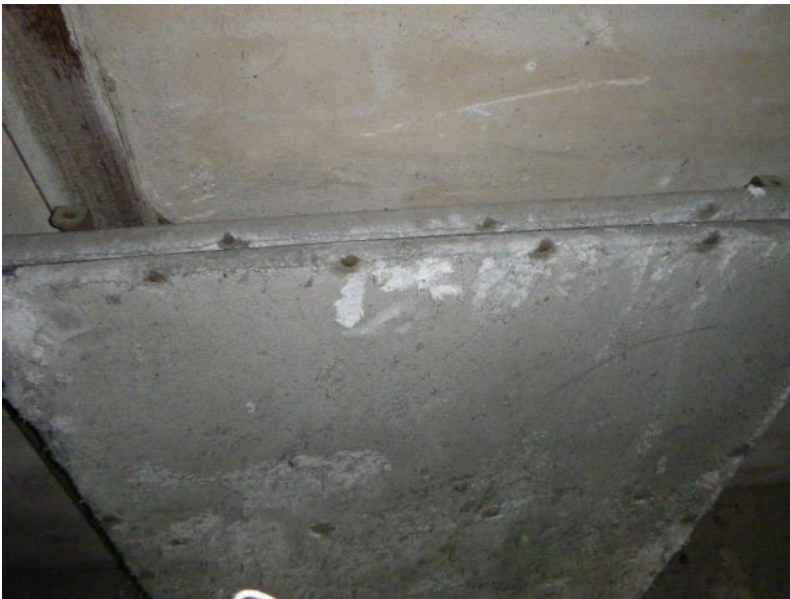
Bild 36: MP23 Asbestplatte
