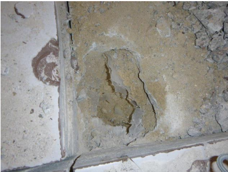
Bild 19: Estrich Sanitärraum Sperrschicht Folie
