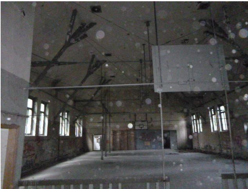
Bild 3: Innenansicht Halle Ost
