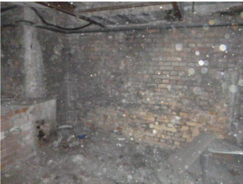
Bild 32: MP19 Heizungskeller Wände
