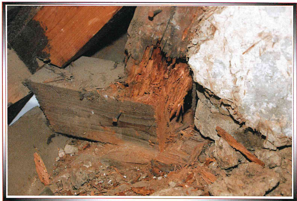
Bild 13 Holzklotz ist kein solides Sparrenaufleger
