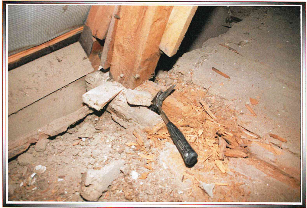
Bild 12 Abenteurliche Verbindung zwischen Sparren und Balkenkopf
