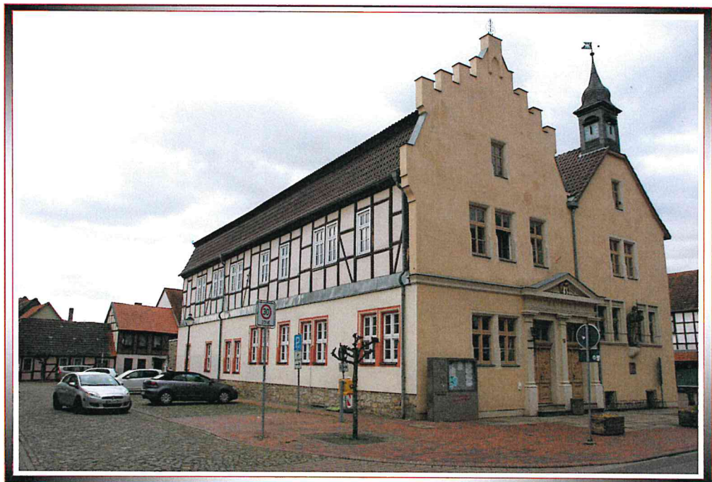
Bild 1 Westansicht vom Gebäude
