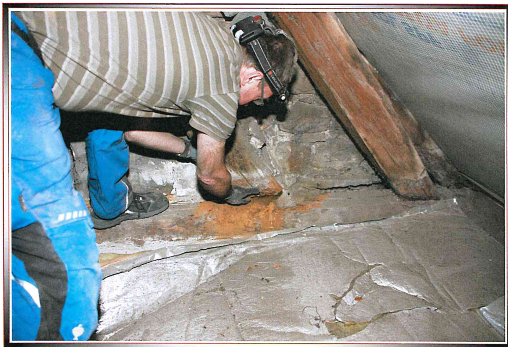
Bild 22 Strebe ohne wirksame Verankerung zum Balkenkopf
