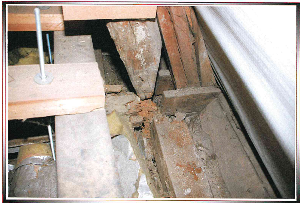
Bild 6 Sparrenfuß ohne Auflager am Balkenkopf (Achse 7)
