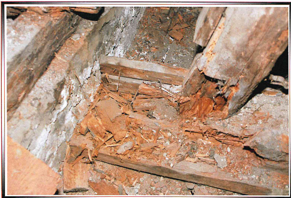
Bild 19 Kaum noch tragfähiger Balkenkopf
