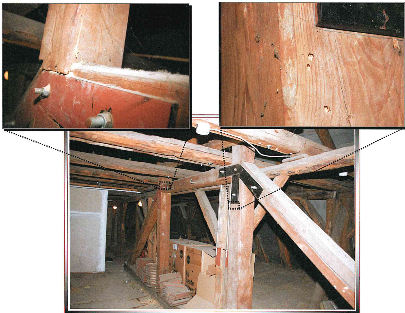
Bild 29 Frisches Bohrmehl (links) und frische Fluglöcher (rechts) vom HB
