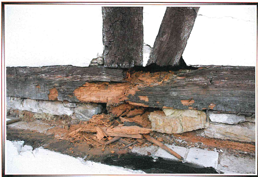
Bild 41 Strebe und Fachwerkstiel ohne Auflager
