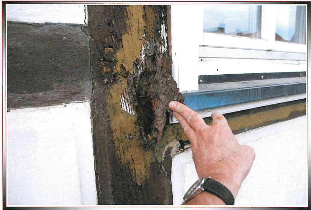
Bild 36 Kunststoffbeschichtungen auf der Holzoberfläche
