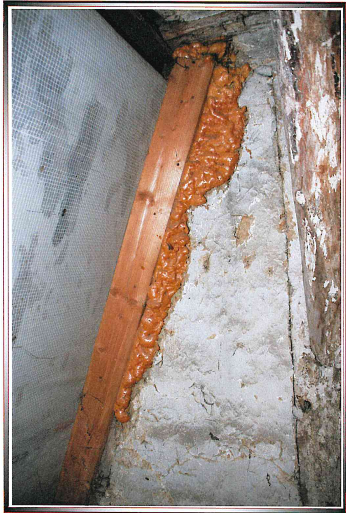
Bild 10 Bauschaum am Ortgangsparren
