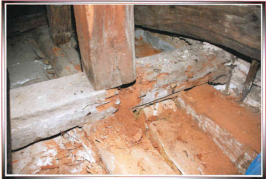
Bild 25 Kaum noch tragfähiger Überzug unter dem Uhrenturm
