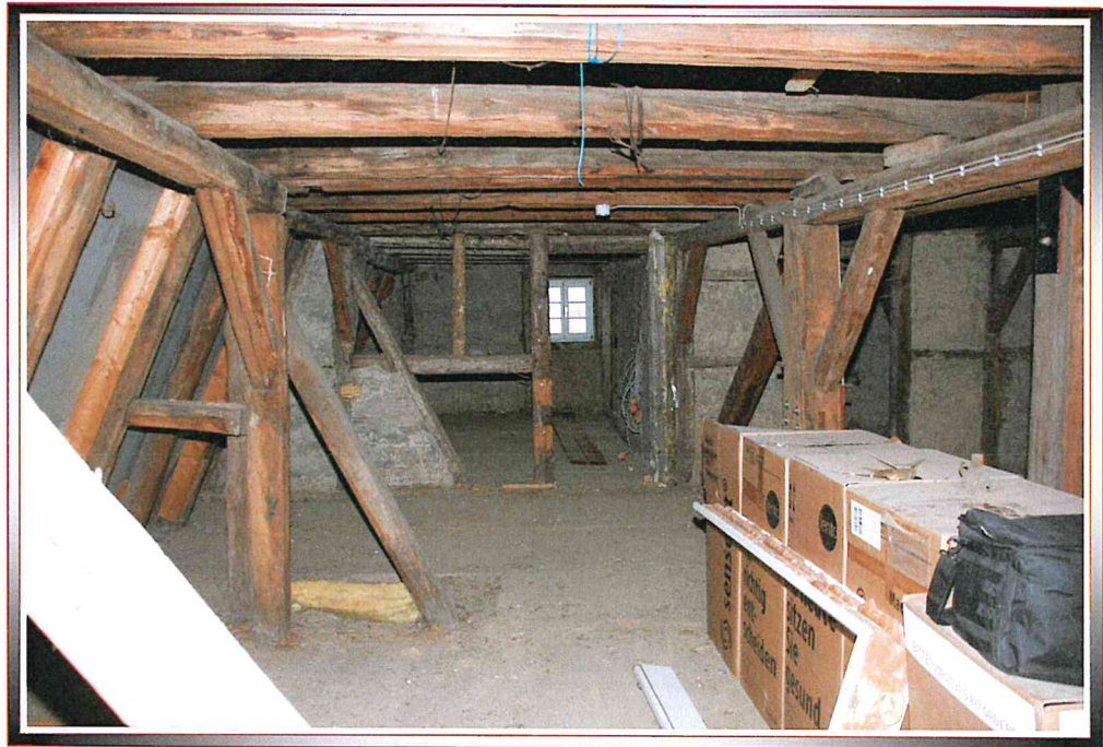
Bild 2 Dachstuhl, Blickrichtung Ost
