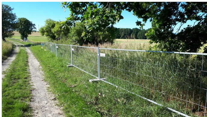
Beispiel eines aufgebauten Schutzzaunes mit Bodenbefestigung durch Holzbohlen bzw. Aufbau Bauzaun (Bereich Nieder Gebelzig)
