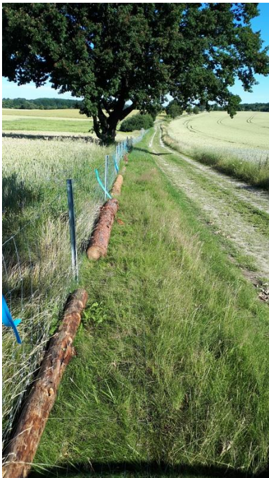
Beispiel eines aufgebauten Schutzzaunes mit Bodenbefestigung durch Holzbohlen bzw. Aufbau Bauzaun (Bereich Nieder Gebelzig)
