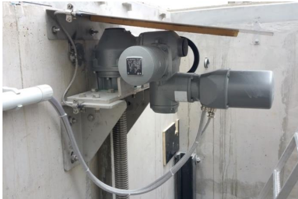
Abbildung 4: Schieberantrieb in Referenzbauwerk
