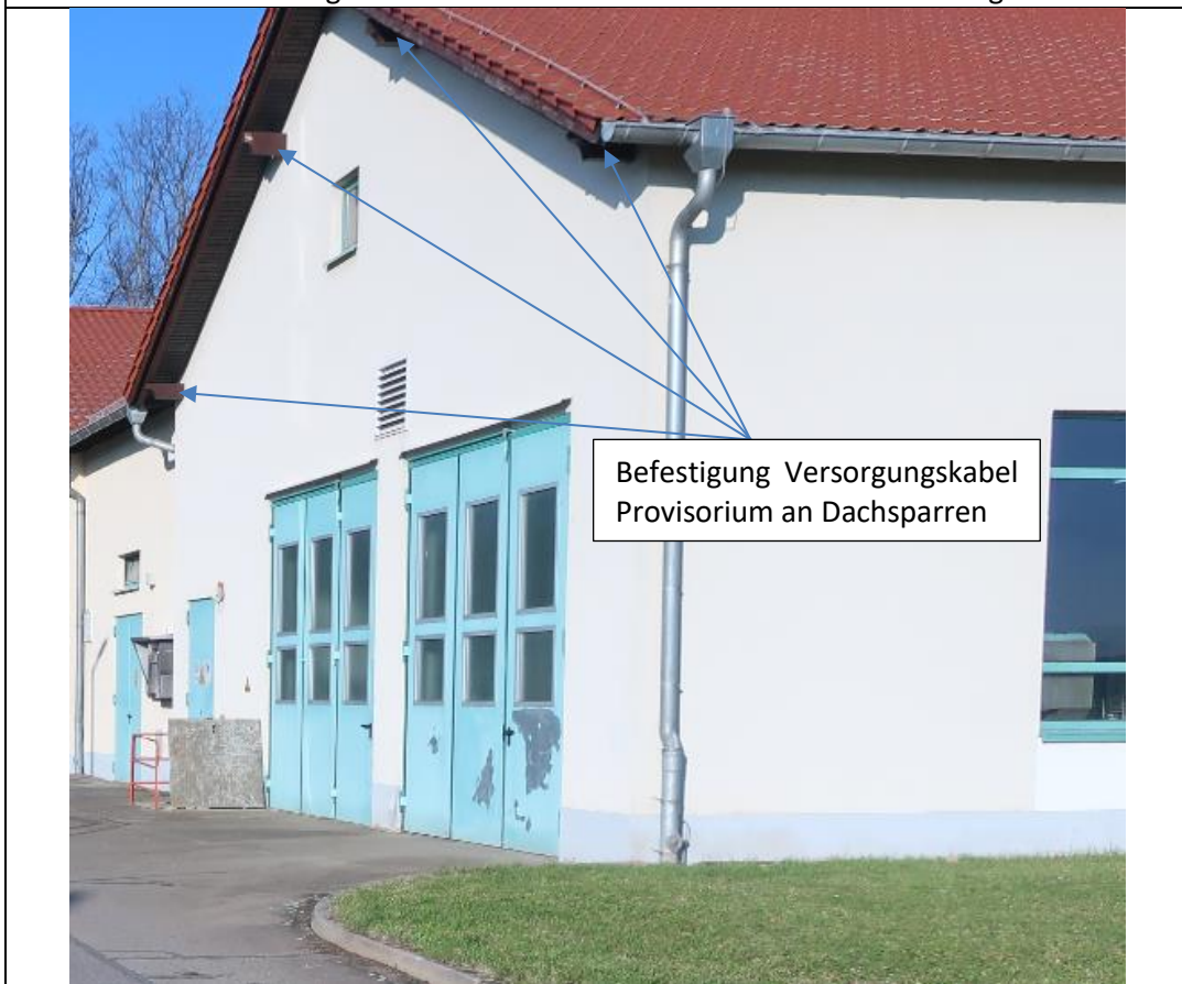
Gebäude der Schlammmentwässerung
