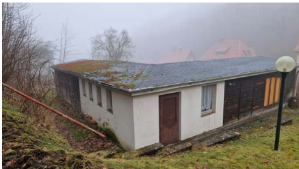
Bild 1 - Ansicht Baubereich von Süden
