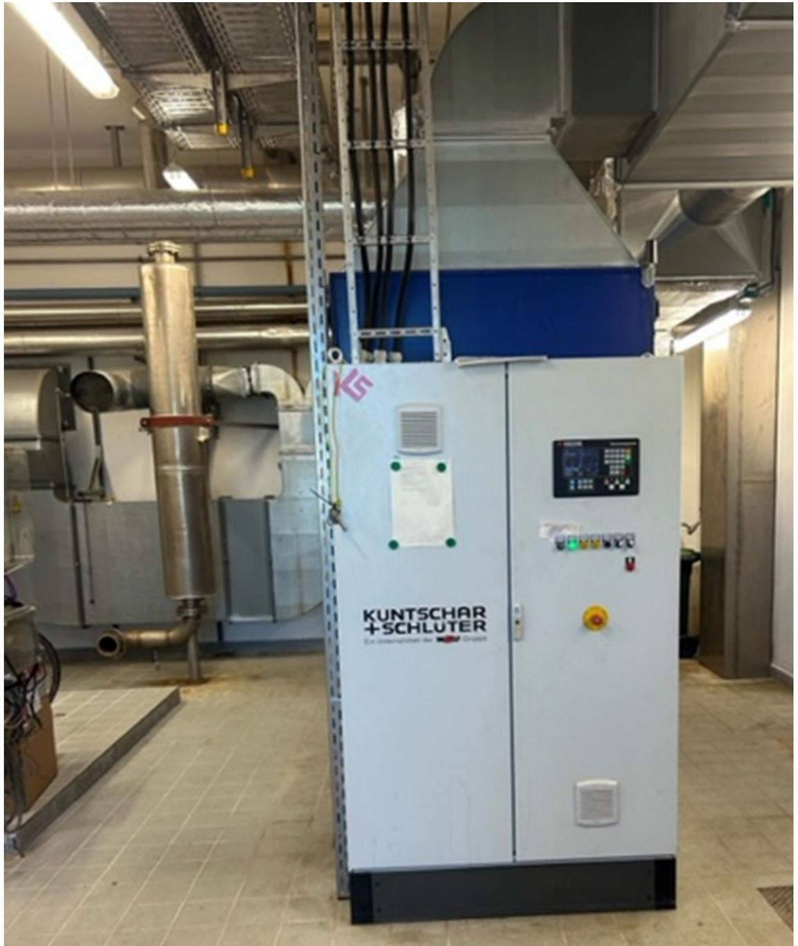
**Abbildung 2-1:** BHKW-Raum mit vorhandener Maschine und freiem Fundamentstellplatz
