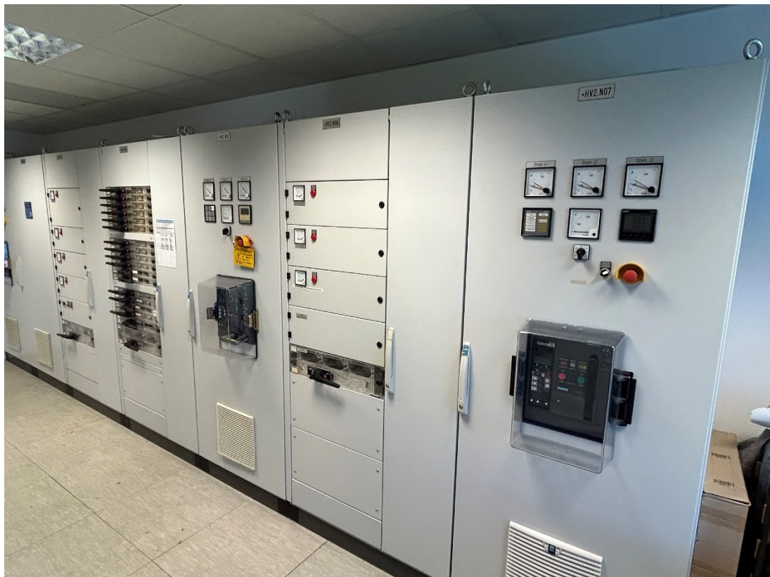
Abbildung 4-1: Niederspannungshauptverteilung
