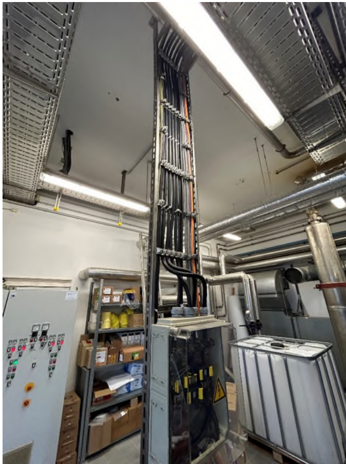
Abbildung 4-7: Kabelführung und Anschlusspunkte
