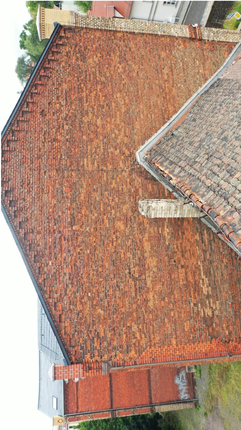
Abbildung 2: Westgiebel das verwandt Ziegelmaterial zeigt flächig Schäden durch Abschalungen und Abplatzungen.
