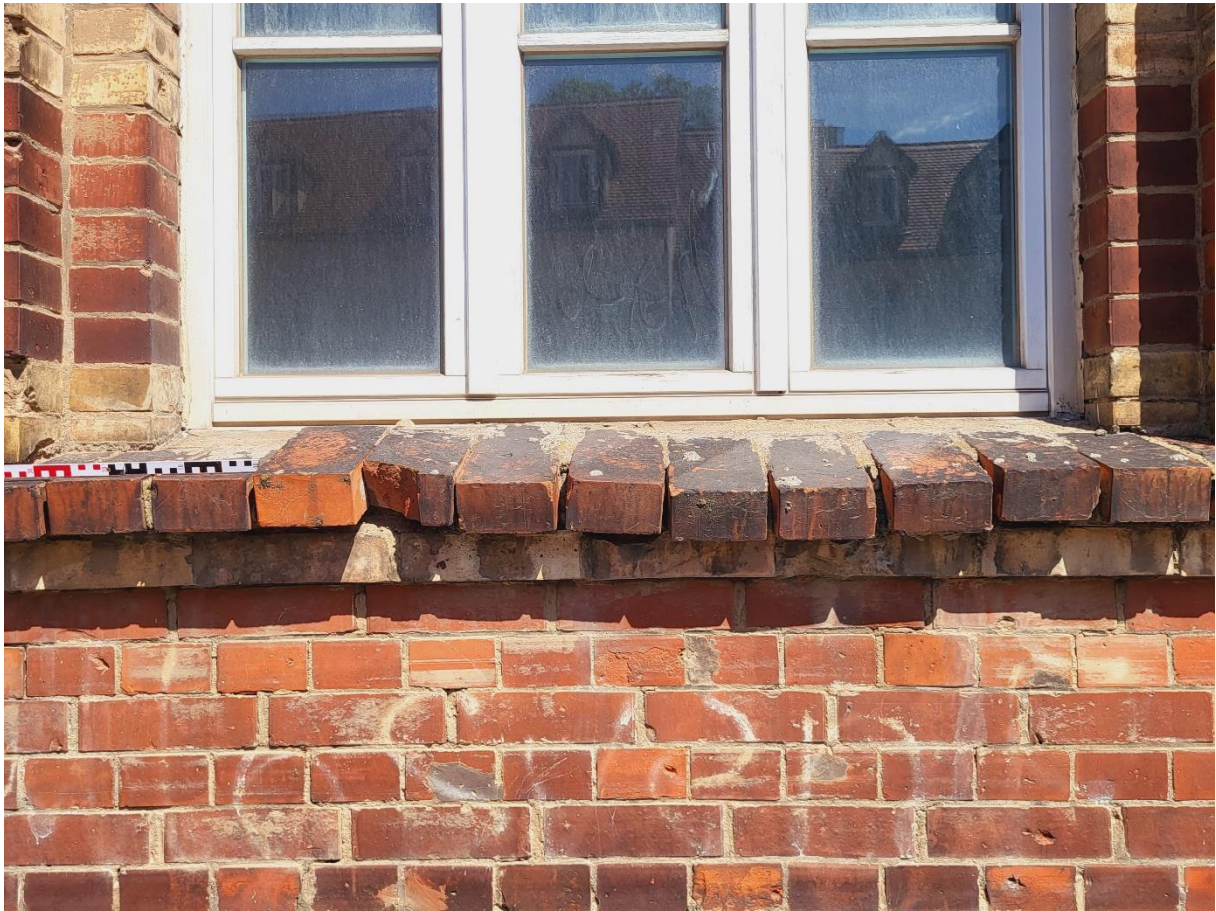
Abbildung 11 Lose liegende Ziegellage im Bereich der Sohlbänke
