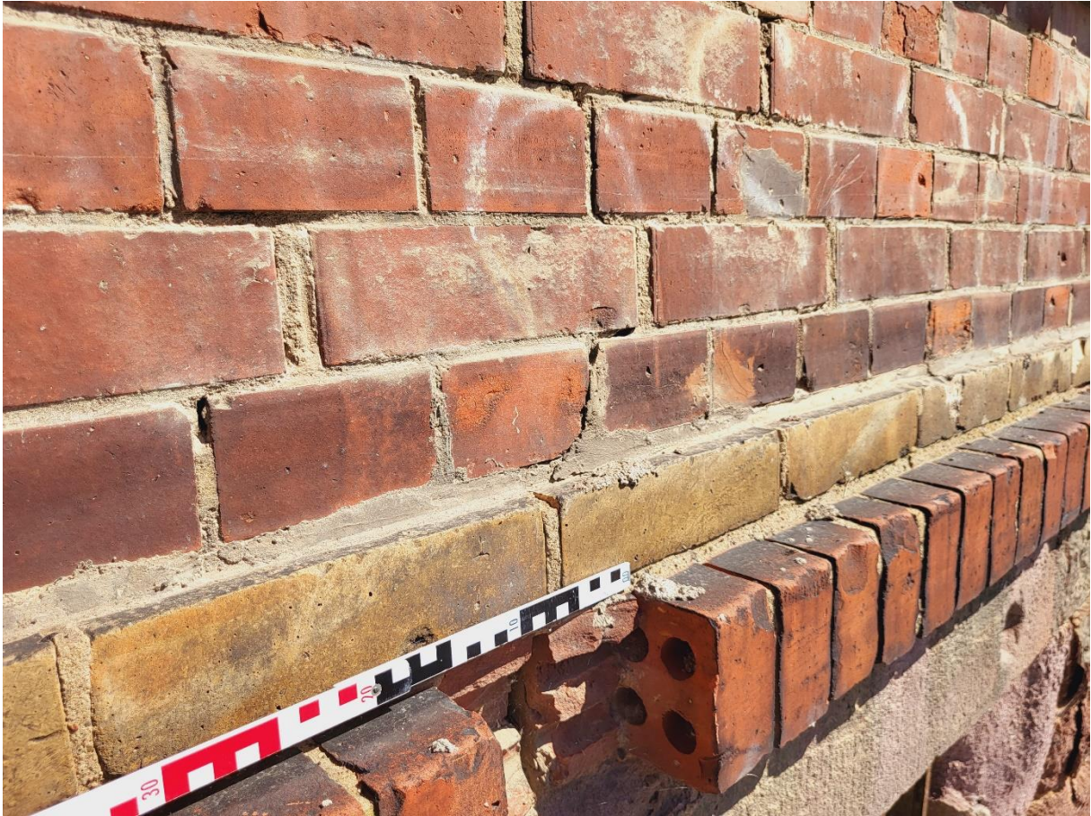
Abbildung 13: Im Bereich des Sockelgesimses sind die verwandten Lochziegel zu erkennen.
