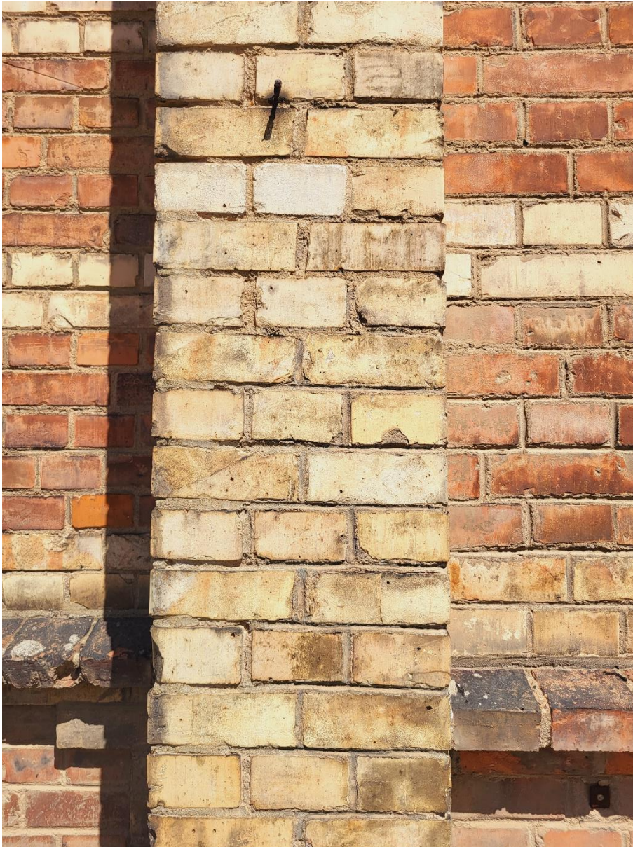
Abbildung 6: Der Fugenbestand am Ursprungsbau zeigt unterschiedliche Erhaltungszustände der Ausfugung auf.
