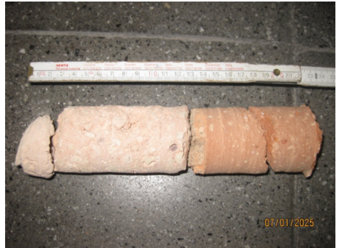
Abb. 8: BV „Neues Rathaus Dresden“. Bohrkern BK 3/W8, 07.01.2025
