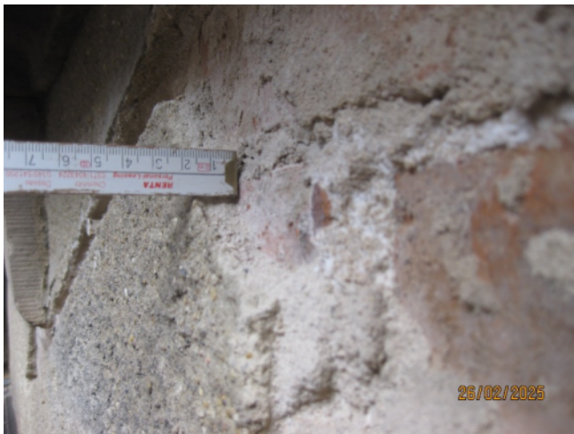
Abb. 23: BV „Neues Rathaus Dresden“. Putzprobe Hof C, 26.02.2025
