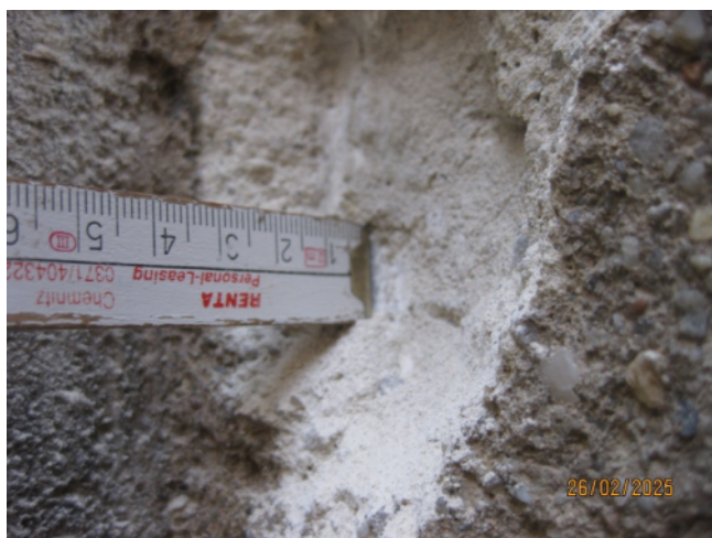
Abb. 25: BV „Neues Rathaus Dresden“. Putzprobe Hof E, 26.02.2025
