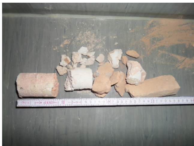
Abb. 2: BV „Neues Rathaus Dresden“. Bohrkern BK E/W2, 17.01.2025
