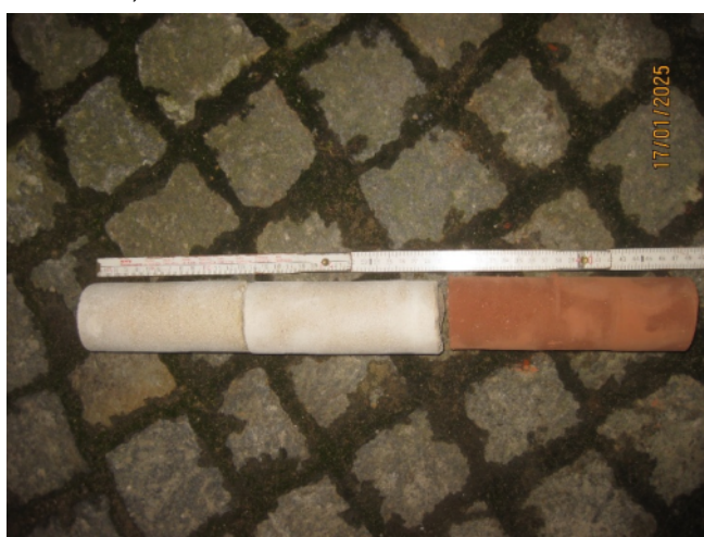
Abb. 3: BV „Neues Rathaus Dresden“. Bohrkern BK E/W3, 17.01.2025
