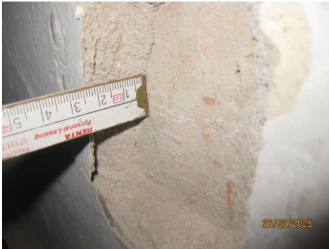
Abb. 13: BV „Neues Rathaus Dresden“. Putzprobe EG, 26.02.2025
