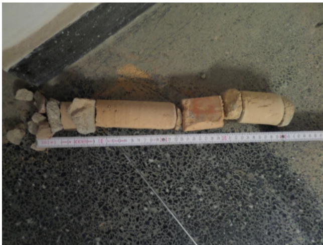
Abb. 11: BV „Neues Rathaus Dresden“. Bohrkern BK 4/W11, 07.01.2025
