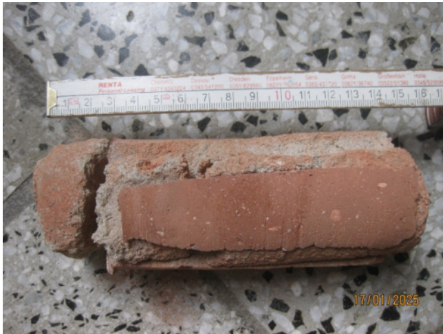
Abb. 7: BV „Neues Rathaus Dresden“. Bohrkern BK 2/W7, 17.01.2025
