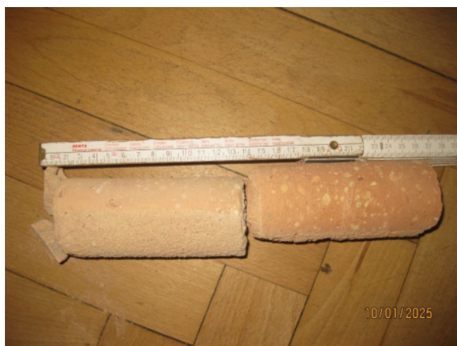
Abb. 6: BV „Neues Rathaus Dresden“. Bohrkern BK 2/W6, 10.01.2025
