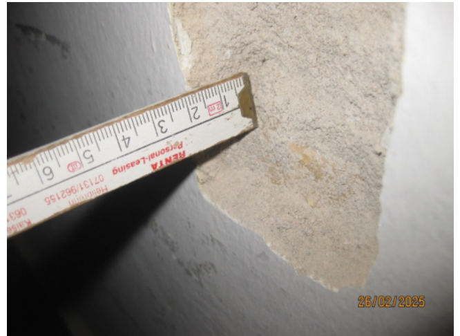
Abb. 14: BV „Neues Rathaus Dresden“. Putzprobe EG, 26.02.2025
