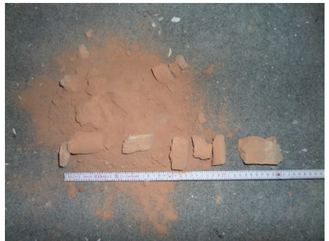
Abb. 10: BV „Neues Rathaus Dresden“. Bohrkern BK 4/W10, 06.01.2025
