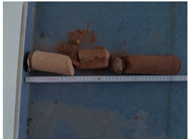
Abb. 12: BV „Neues Rathaus Dresden“. Bohrkern BK 4/W12, 07.01.2025
