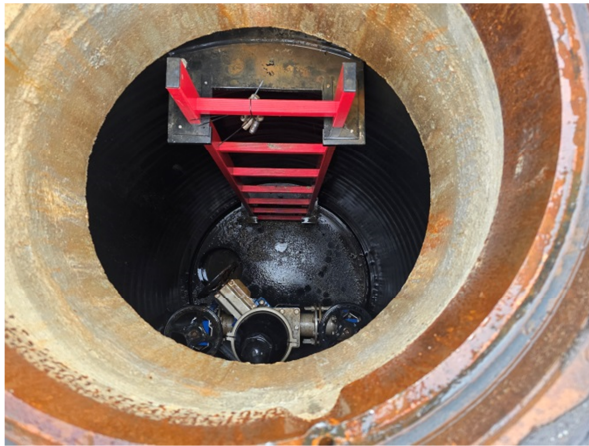
Abbildung 9: Anordnung Be-/Entlüftungsventil im Schacht
