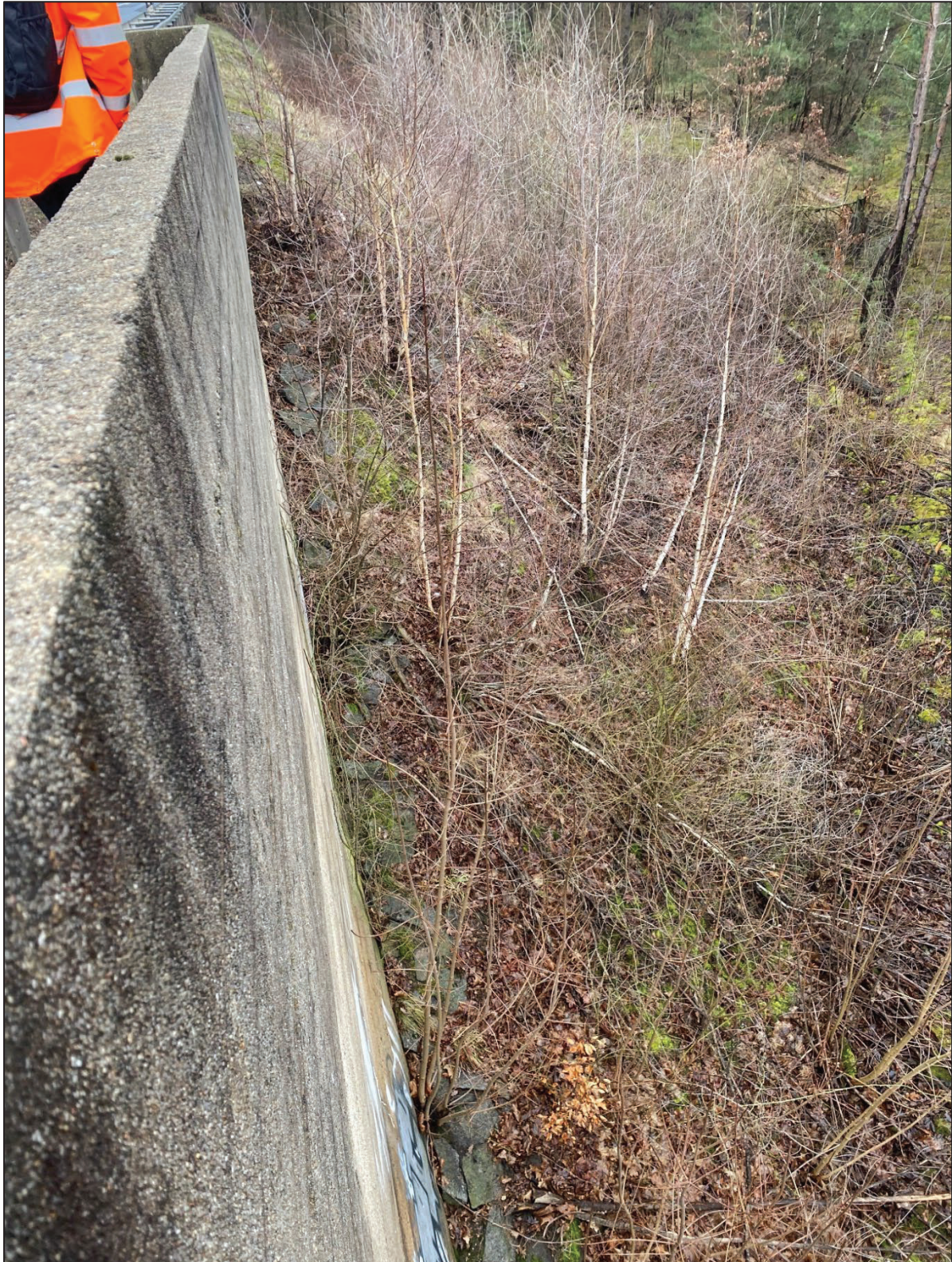
Brüstungswand Parallelflügel und Steilböschung mit Bewuchs und Steinsatz
