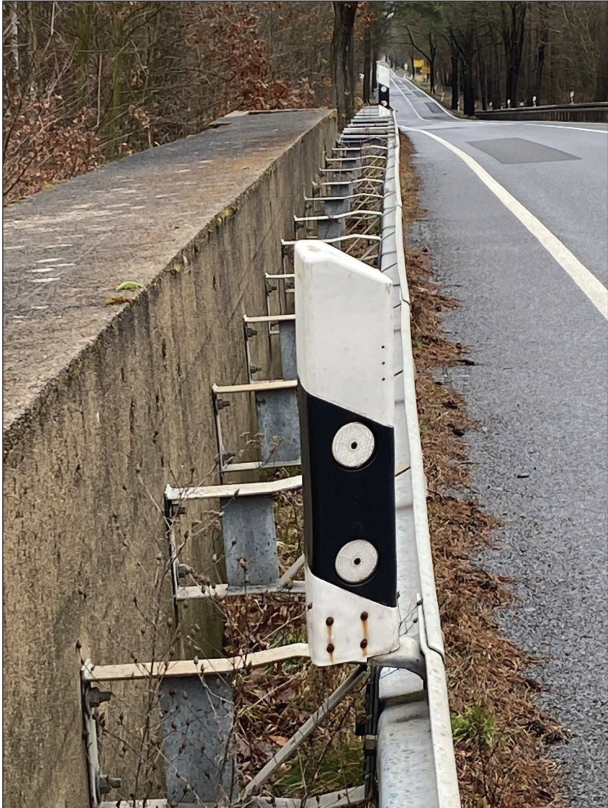
Brüstungsteil Hauptlängsträger und Schutzplanke mit Sonderverankerung
