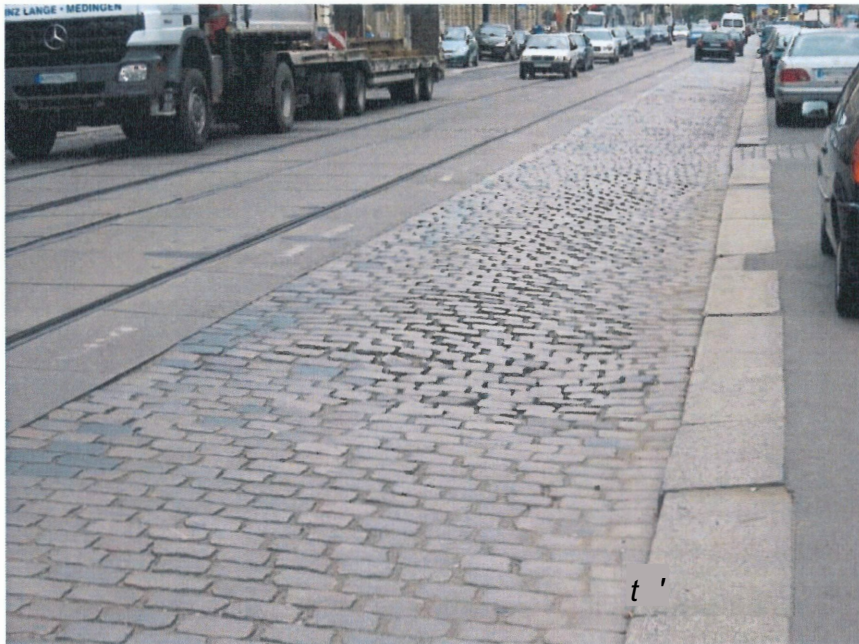
Abbildung 3: Fahrbahnbelag aus Pflasterbefestigung
