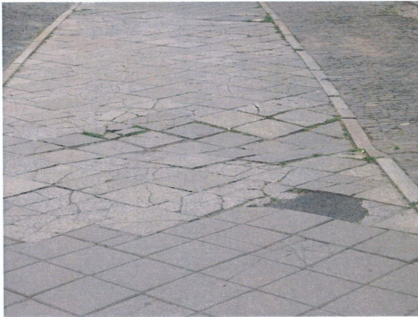
Abbildung 8: Gehweg mit schadhafter Befestigung
