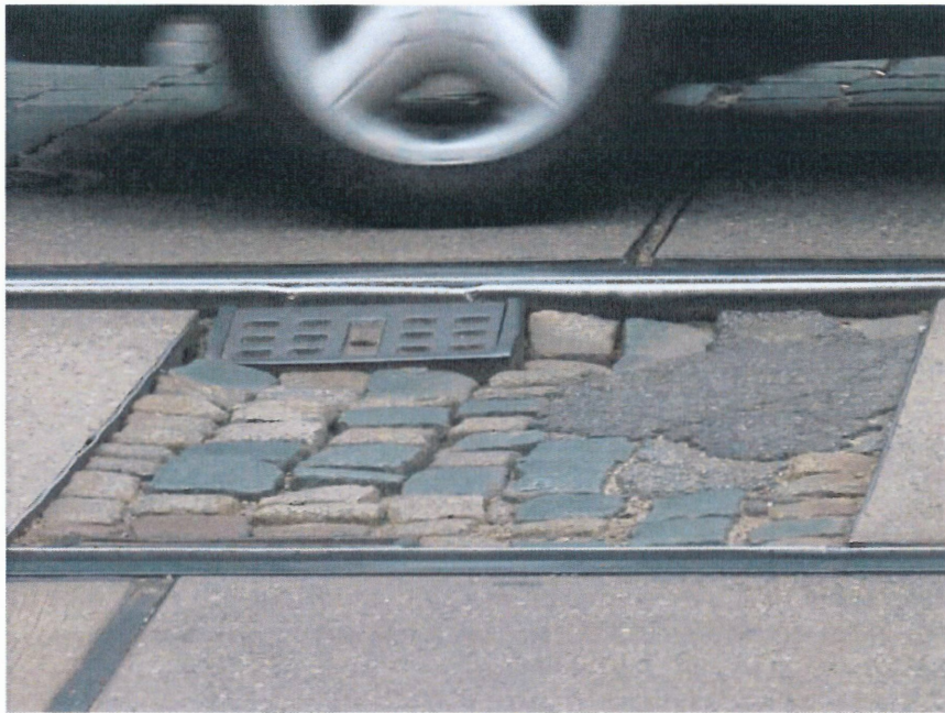
Abbildung 5: Gleisbereich mit schadhafter Gleiseindeckung
