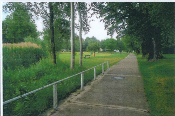
Überdeckelung des Kaitzbaches im Naturbad Mockritz, Nutzung als Weg, im Hintergrund der Liegewiesenbereich
