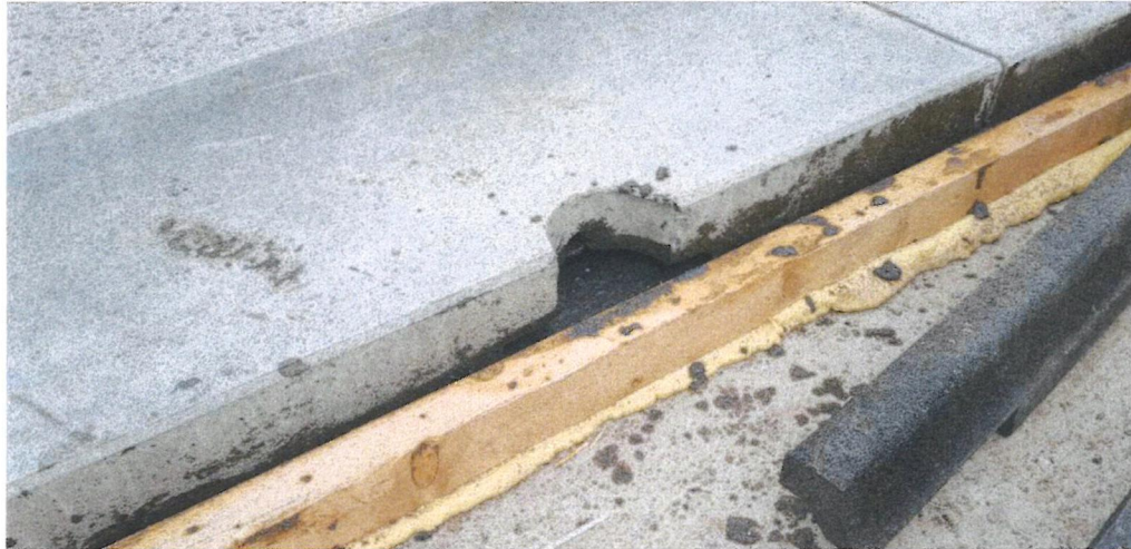
Abbildung 13 - Beispiel Ausführung Schalung an der schienenzugewandten Seite - ohne Schiene
