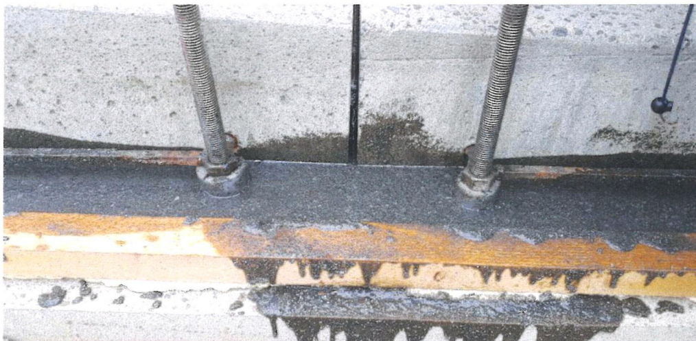
Abbildung 10 - Schutz der Spindelelemente Bild Hansastrasse BF Neustadt [2023-04-20-114808]
