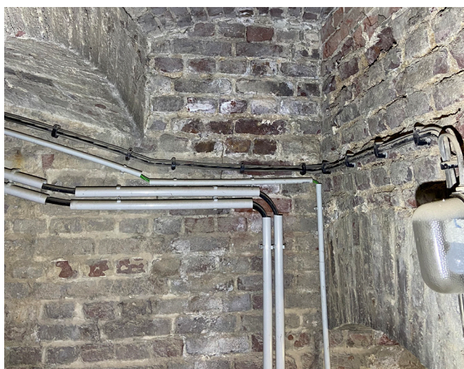
BT 03 - Gangsystem, Position neu geplante Tür, Zwischengeschoss Blick nach oben
