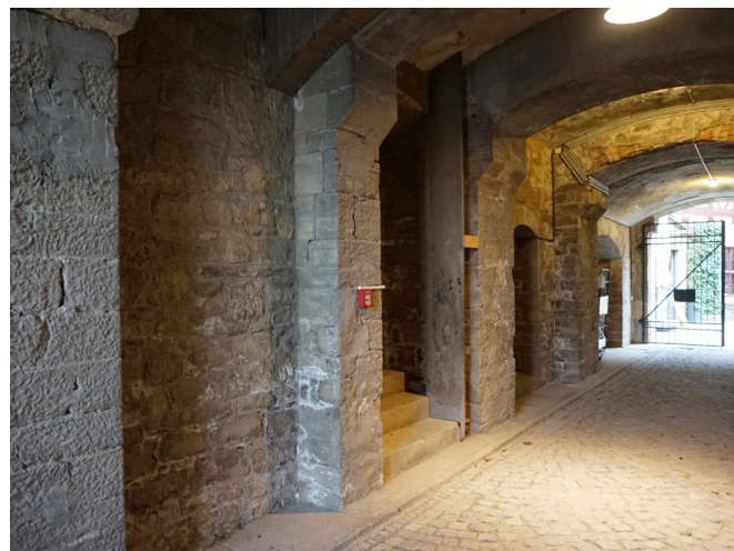
BT 13 - R 1.1.35, EG, Durchfahrt, geplante Türöffnung (links)
