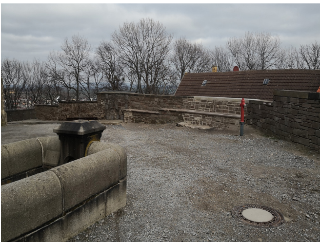
BT 8 - Innenring / oberhalb an Frühlingsbau und Kirchgang
