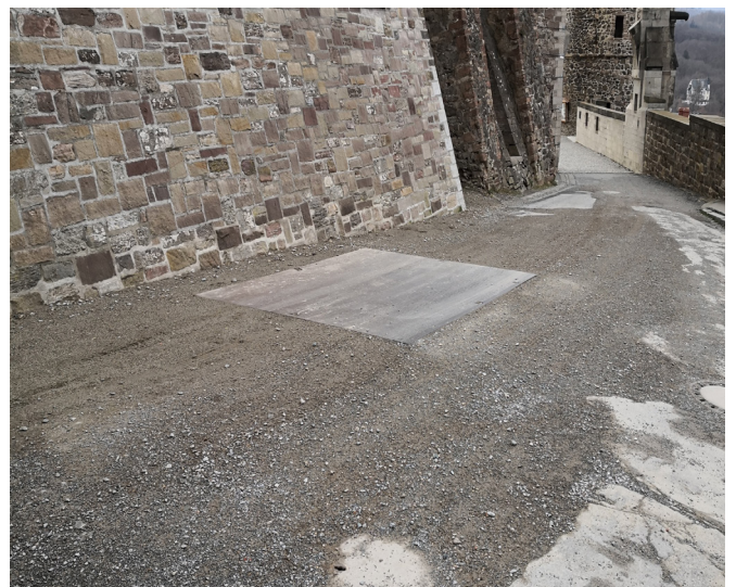
BT 10 - Brunnen im Innenring / unterirdisch
