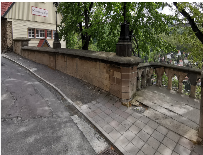
BT 16 - Stützmauer an Terrasse
