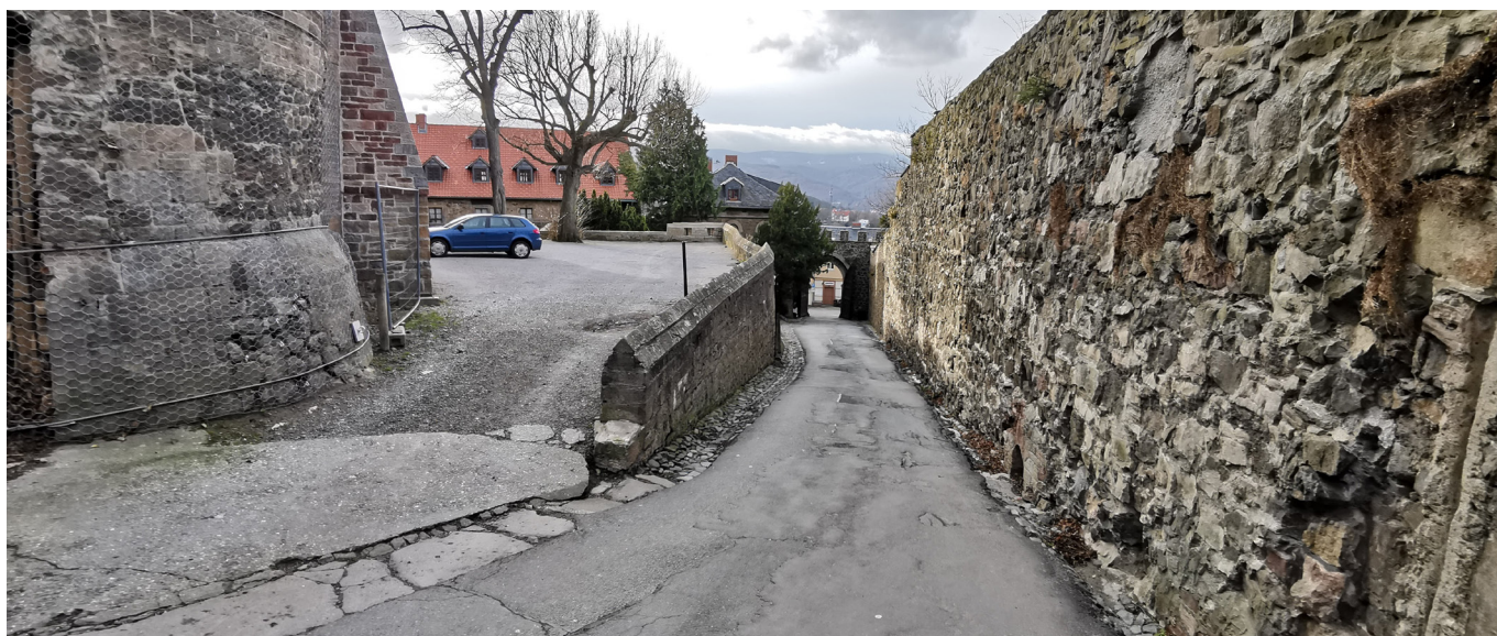
BT 1 - Schlossstraße / unterer Teil mit Blick auf Zufahrt Bäckerhof
