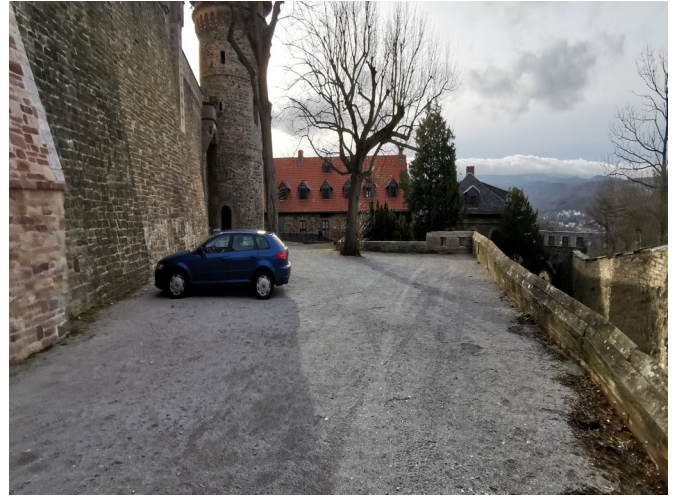
BT 2 - Bäckerhof / Zufahrt- Blick zum Hausmannsturm
