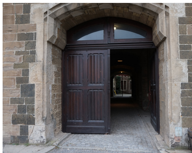
BT 13 - R 1.1.35, EG, Eingang zur Durchfahrt vom Innenring
