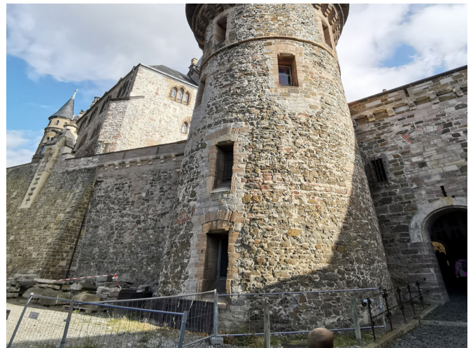
BT 3 - Hausmannsturm / unterhalb Bäckerhof vor Tunnelausgang
