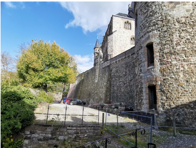
BT 2 - Bäckerhof / Zufahrt- Blick vom Tunnelausgang
