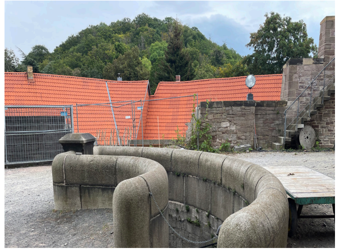
BT 6 - Kirchgang / oberhalb vor Frühlingsbau
