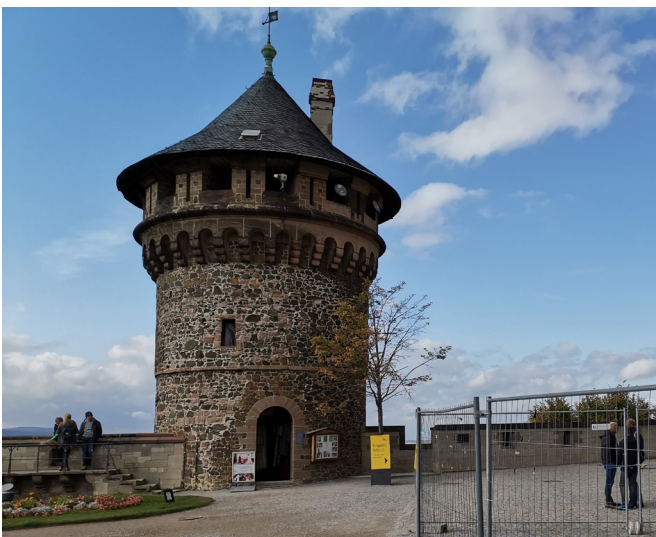
BT 2 - Bäckerhof / Stützmauer zur Schlossstraße
