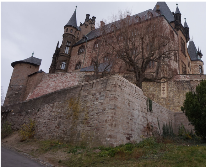
BT 2 - Bäckerhof / Stützmauer zur Schlosstraße
