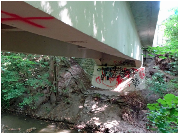
S50 BÖSCHUNG AUSGESPÜLT WL VORN
