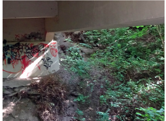
S31 BÖSCHUNGSPFLASTER UNVOLLSTÄNDIG WL VORN LINKS
