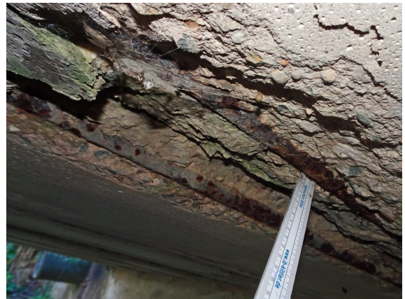
S13 FREILIEGENDE BEWEHRUNG MIT QUERSCHNITTMINDERUNG
