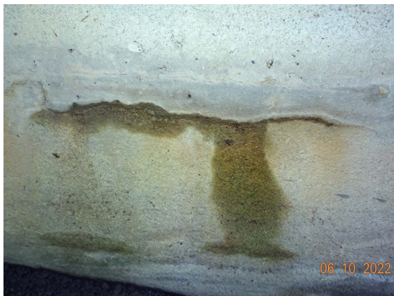
S6 WDL VORN QUERRISS MIT WASSERAUSTRITT
