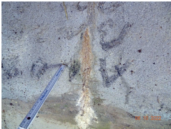
S9 WDL HINTEN LÄNGSRISSE MIT AUSSINTERUNG
