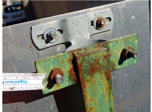
S24 PROFIL UND MUTTERN DER BESCHILDERUNG ANGEROSTET
