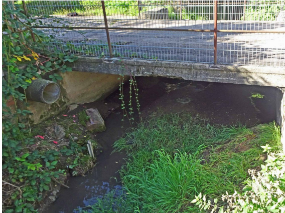
S15 DURCHFLUSSQUERSCHNITT EINGEENGT [20] S=0, V=0, D=2 BSP-ID 251-03
